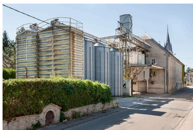
Vue d'ensemble depuis la route du Val. Phot. Jérôme Mongreville IVR43_20162501159NUC4A
