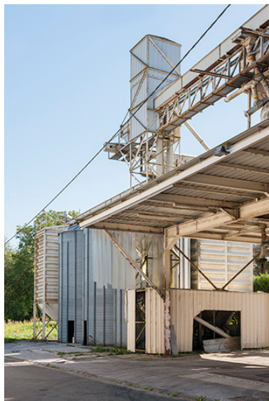
Installations de chargement/déchargement. Phot. Jérôme Mongreville IVR43_20162501156NUC4A
