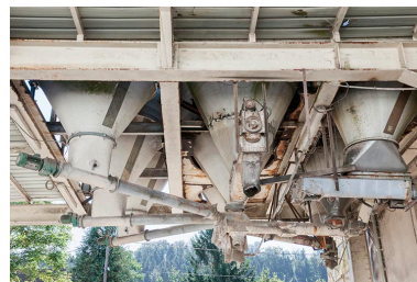
Trémiés de chargement. Phot. Jérôme Mongreville IVR43_20162501157NUC4A
