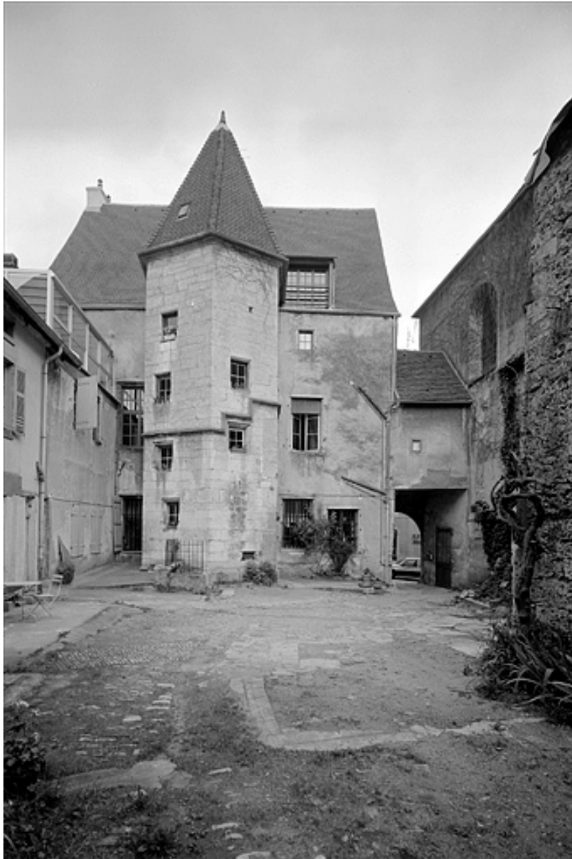
Façade postérieure avec tour d'escalier hors-oeuvre.
