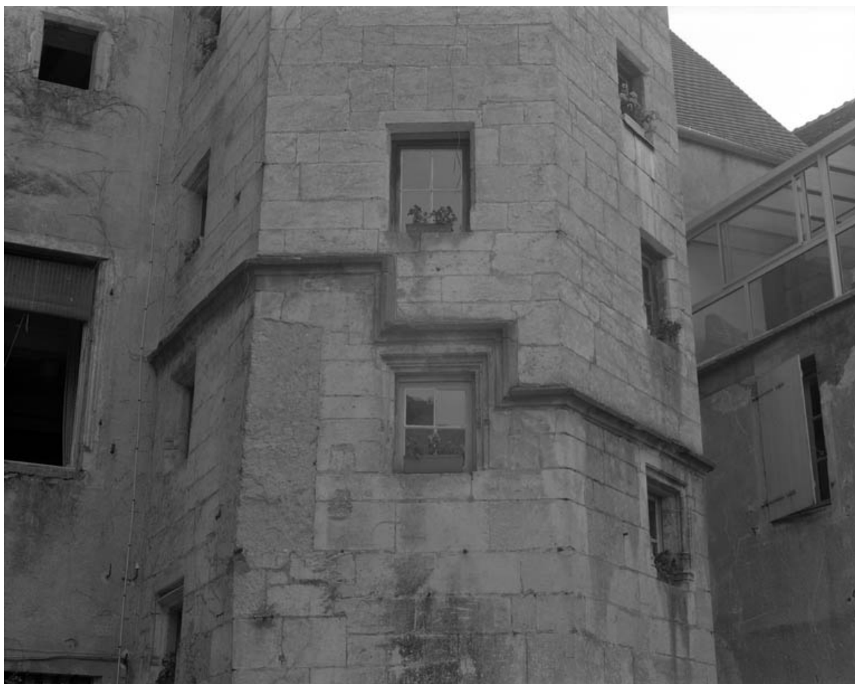
Façade postérieure. Détail : baies de l'escalier hors-oeuvre.
