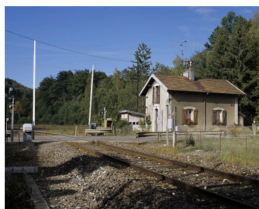
Façades antérieure et latérale droite. Phot. Yves Sancey IVR43_20043900190XA
