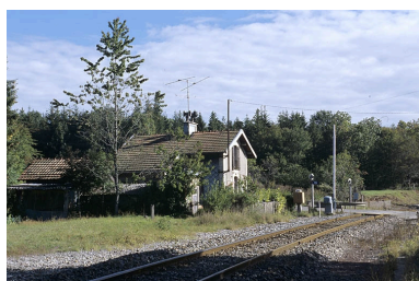
Vue d'ensemble, depuis l'ouest. Phot. Yves Sancey IVR43_20043900193ZA
