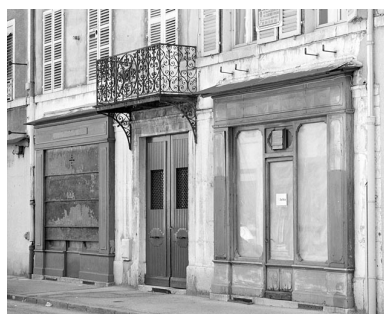
Boutiques au rez-de-chaussée. Phot. Yves Sancey IVR43_20033900482X
