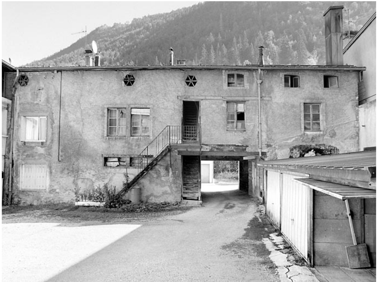
Bâtiment en fond de cour.
