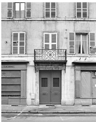
Entrée principale et porte- fenêtre du premier étage. Phot. Yves Sancey IVR43_20033900483X
