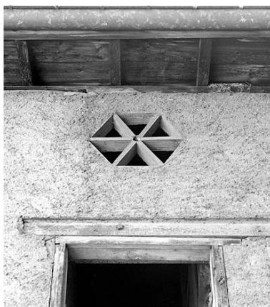
Bâtiment en fond de cour : oculus hexagonal. Phot. Yves Sancey IVR43_20033900491X
