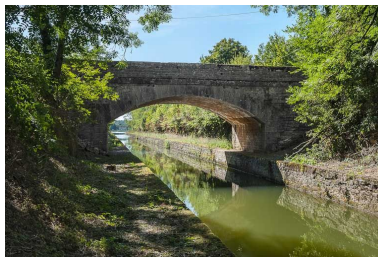
Vue du pont depuis l'amont. Phot. Pierre-Marie Barbe-Richaud IVR26_20122101886NUC4AQ
