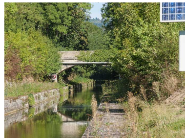
Vue du pont depuis l'aval. Phot. Pierre-Marie Barbe-Richaud IVR26_20122101885NUC2AQ
