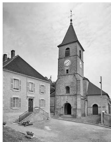
Montmorot : église Saint-Grégoire. Phot. Yves Sancey IVR43_19853900219V
