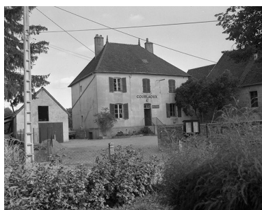
Courlaoux : mairie. Phot. Yves Sancey IVR43_19843900154X
