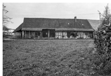
Courlaoux : ferme. Phot. Jérôme Mongreville IVR43_19853900046X
