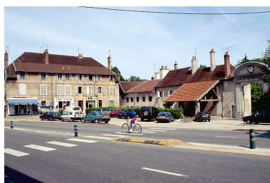
Montmorot : saline (entrée et logement d'ouvriers). Phot. Jérôme Mongreville IVR43_19963900555ZA
