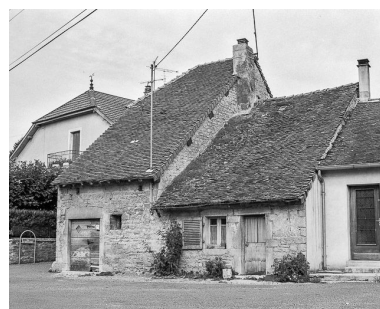
Messia-sur-Sorne : ferme. Phot. Yves Sancey IVR43_19843900266X
