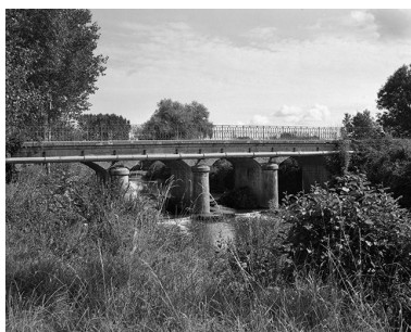
Courlaoux : pont sur la Vallière. Phot. Yves Sancey IVR43_19843900152X
