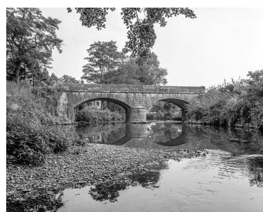
Condamine : pont sur la Vallière. Phot. Yves Sancey IVR43_19843900021X
