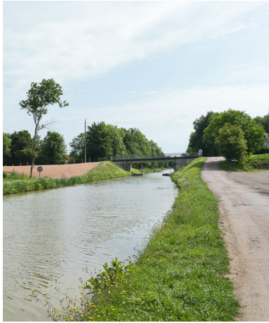
Vue d'ensemble du pont et du site. Phot. Pierre-Marie Barbe-Richaud IVR26_20175800150NUC2A
