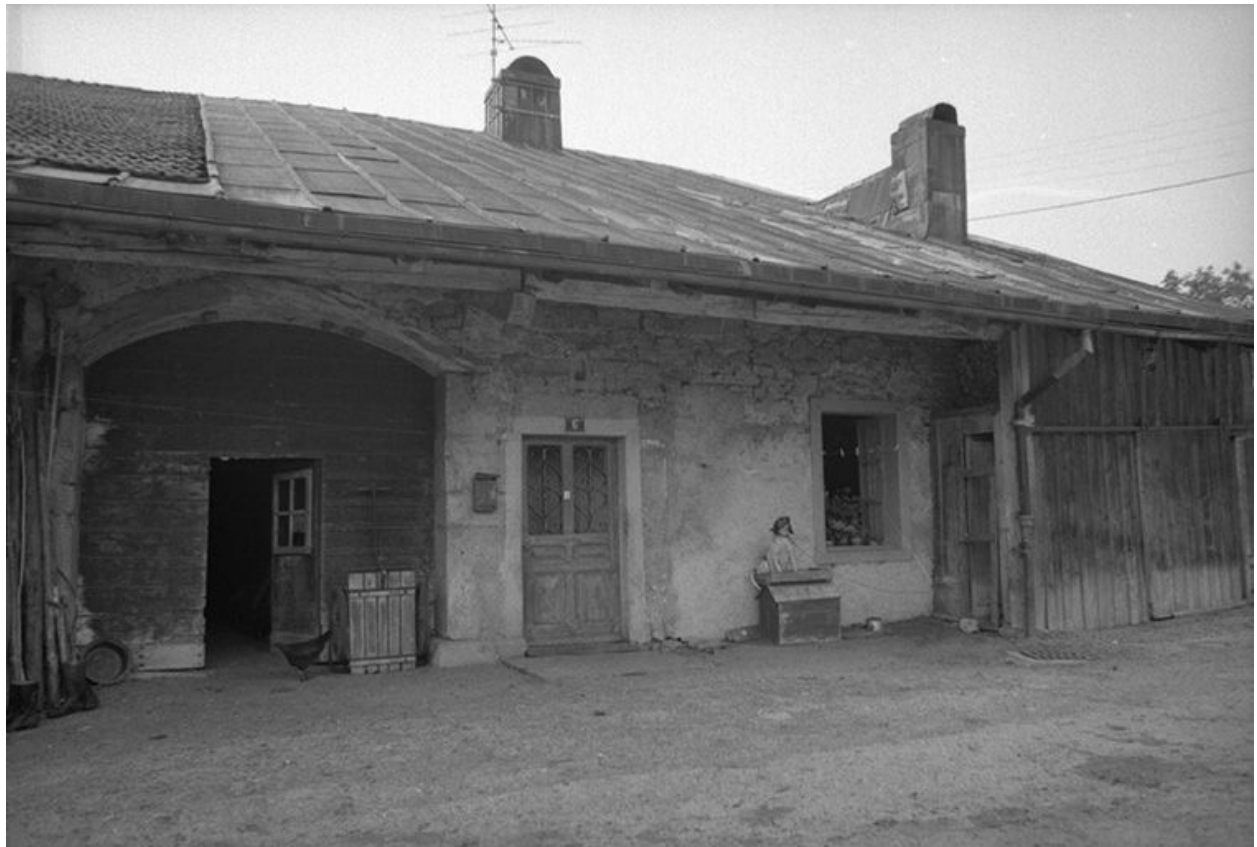
Façade latérale droite.
