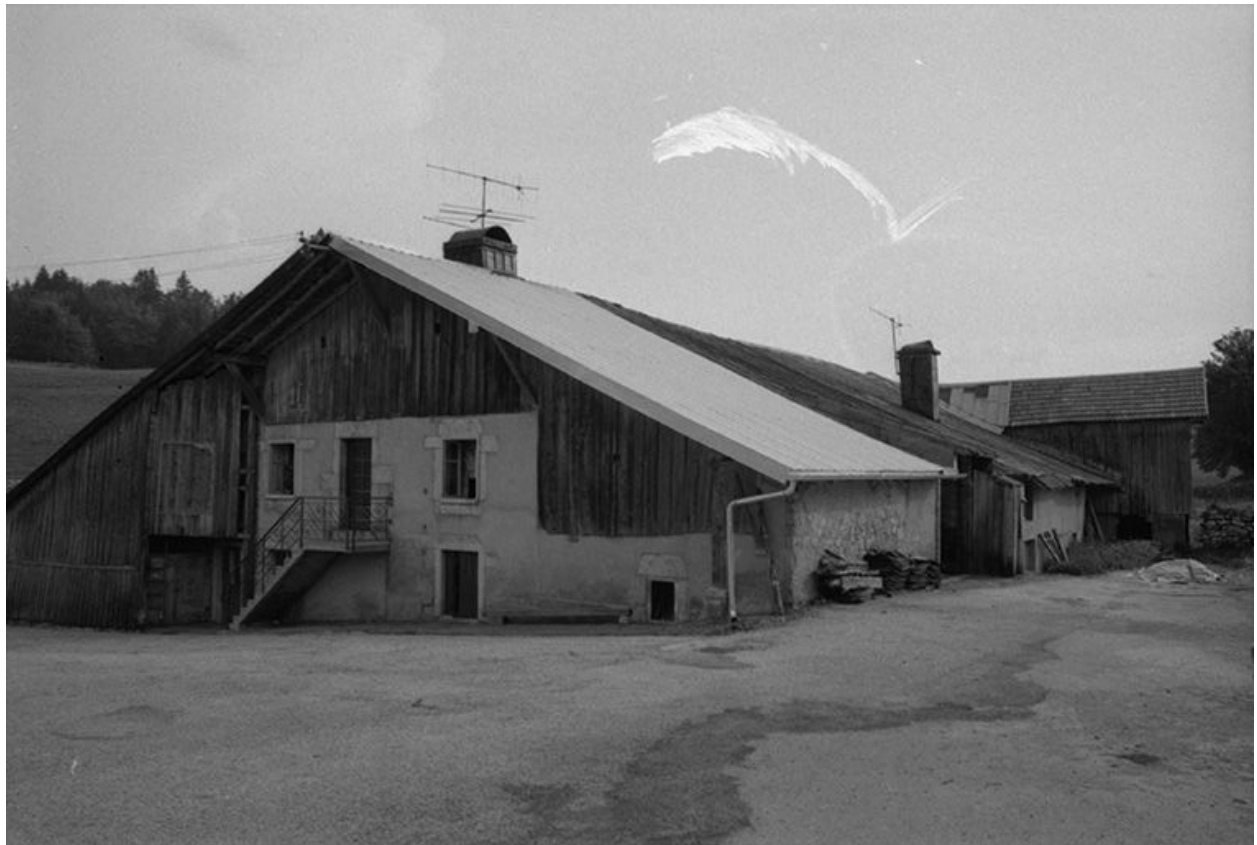
Façades antérieure et latérale droite.
