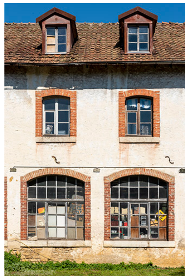
Atelier principal : baies de la façade latérale droite. Phot. Sonia Dourlot IVR43_20192501415NUC4A
