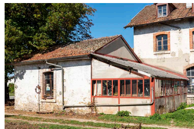
Forge et dépôt : façades postérieure et latérale droite. Phot. Sonia Dourlot IVR43_20192501410NUC4A
