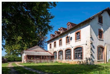
Forge (façade postérieure) et atelier principal (façade latérale droite). Phot. Sonia Dourlot IVR43_20192501412NUC4A
