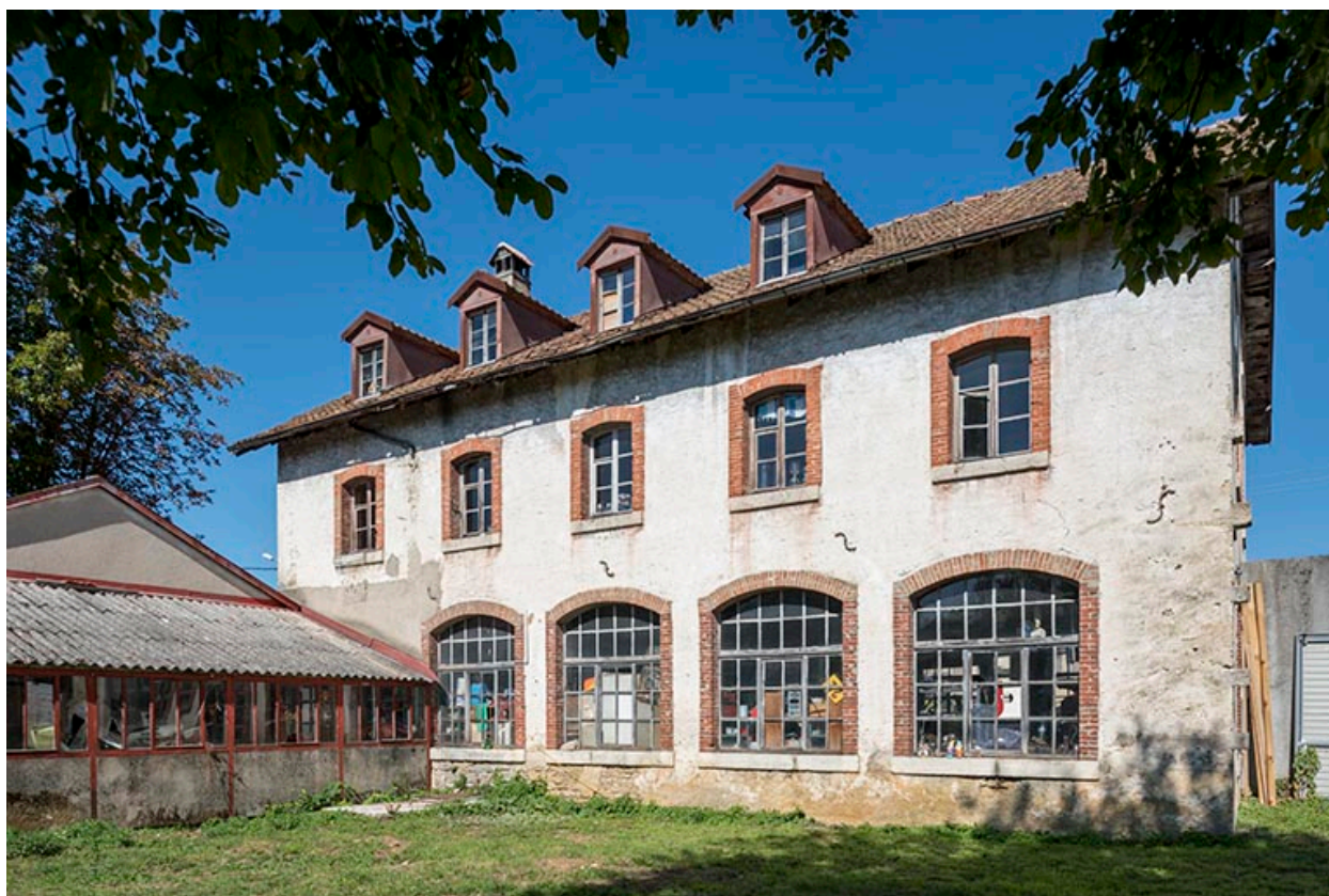
Atelier principal : façade latérale droite, de trois quarts.
