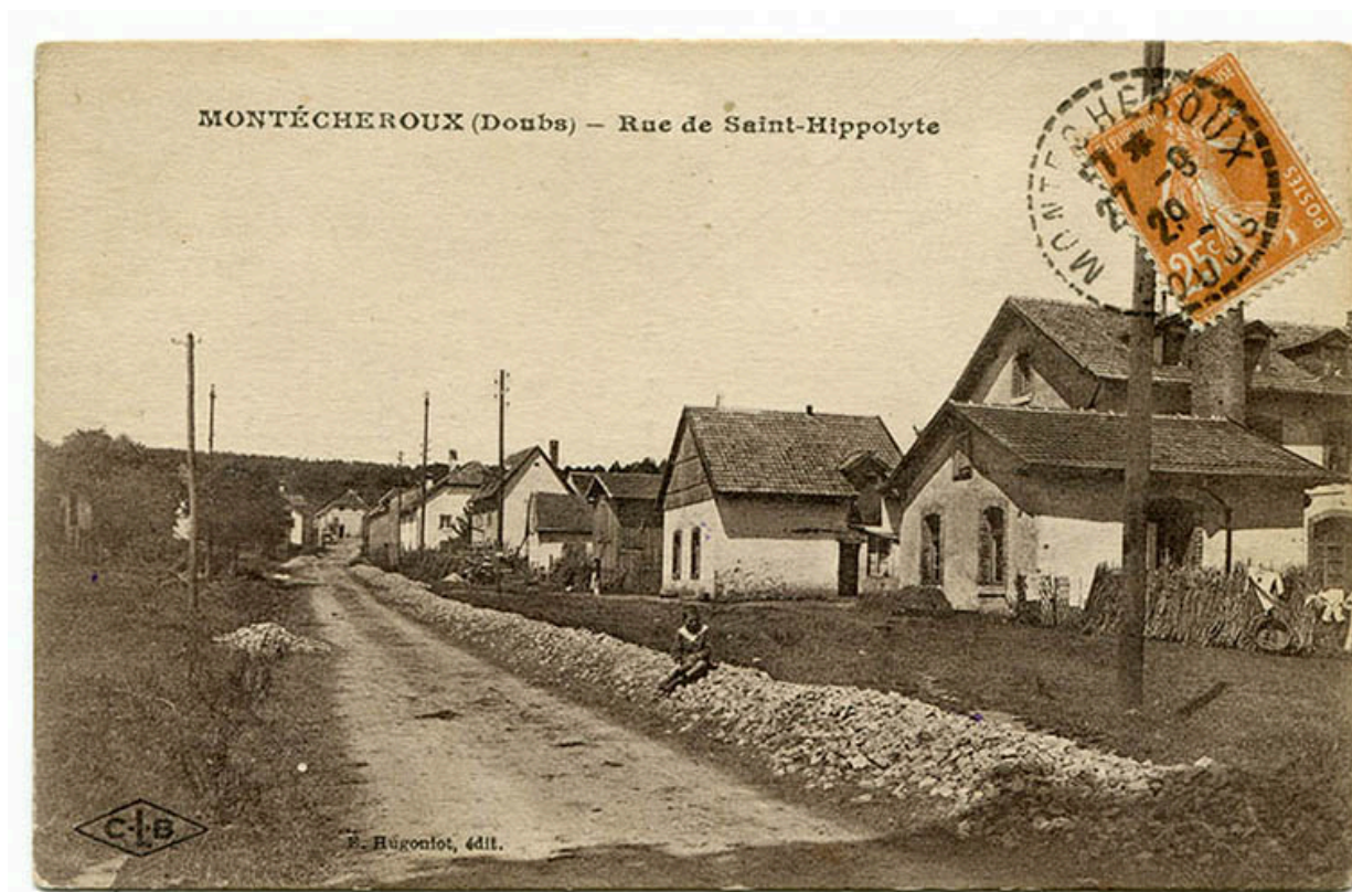
Montécheroux (Doubs) - Rue de Saint-Hippolyte, [1er quart 20e siècle].
