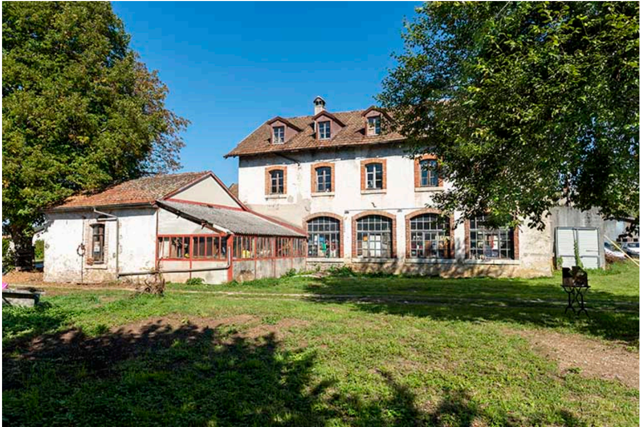
Atelier principal et forge, depuis le sud (façades latérales droite).
