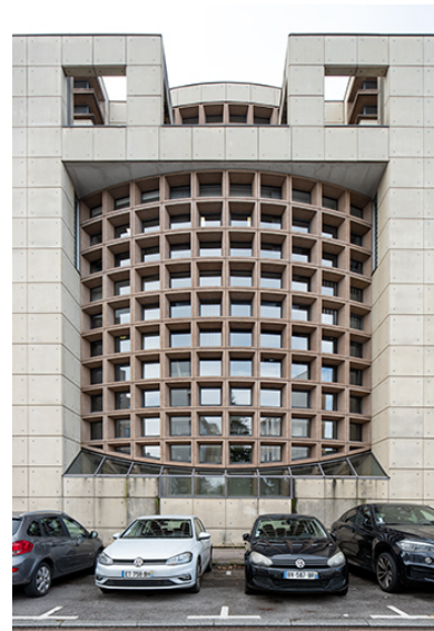
Façade sur la rue François-Mauriac, détail : baies de la salle d'audience du tribunal de grande instance. Phot. Nicolas Waltefaugle IVR26_20262100124NUC4
