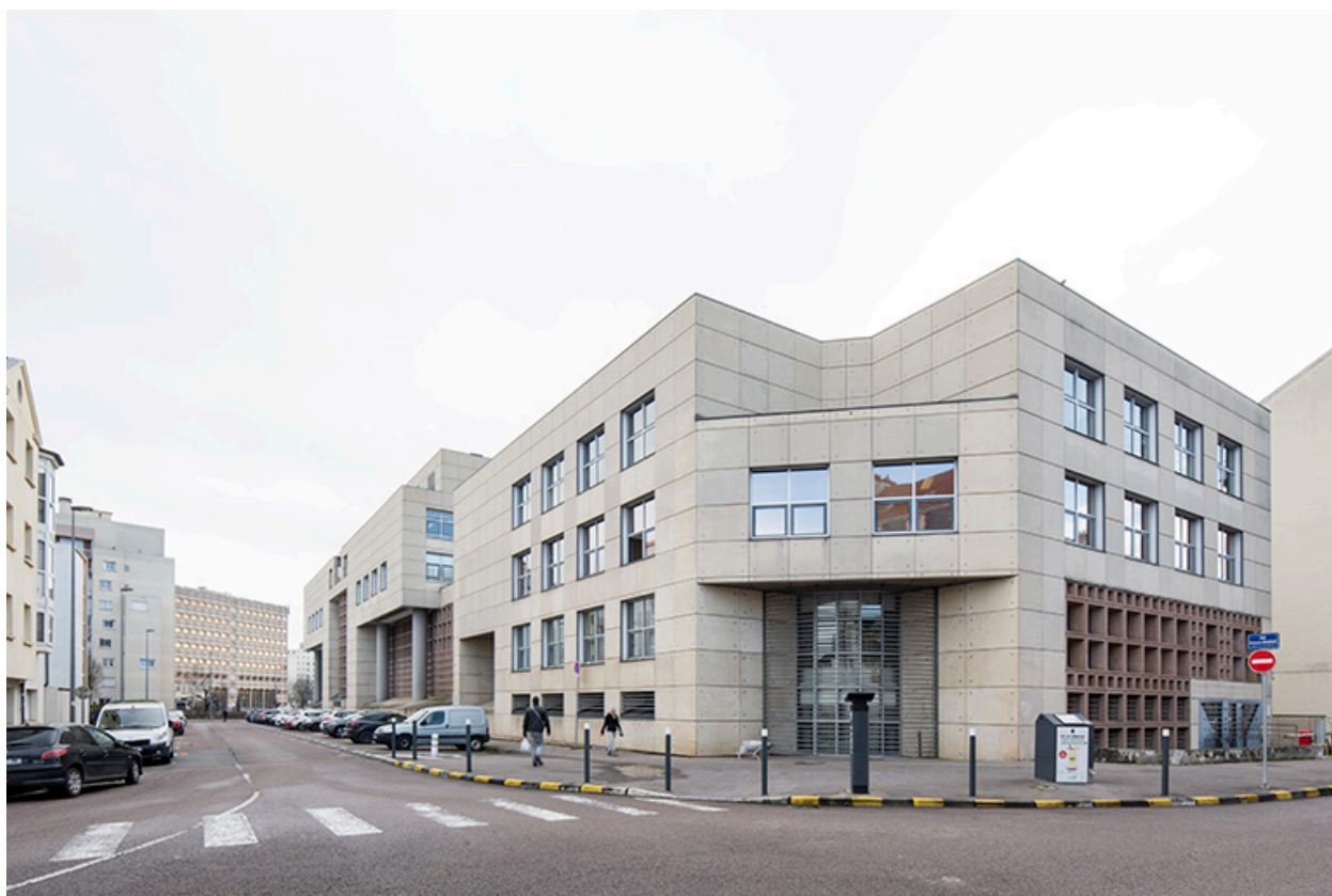
Façade sur la rue François-Mauriac, vue depuis l'ouest.
