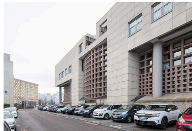
Façade sur la rue François-Mauriac. Phot. Nicolas Waltefaugle IVR26_20262100136NUC4
