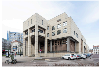
Façade sur la rue François-Mauriac, vue depuis l'est. Phot. Nicolas Waltefaugle IVR26_20262100126NUC4
