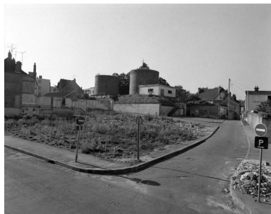
Vue d'ensemble éloignée. Phot. Yves Sancey IVR43_19887000112X
