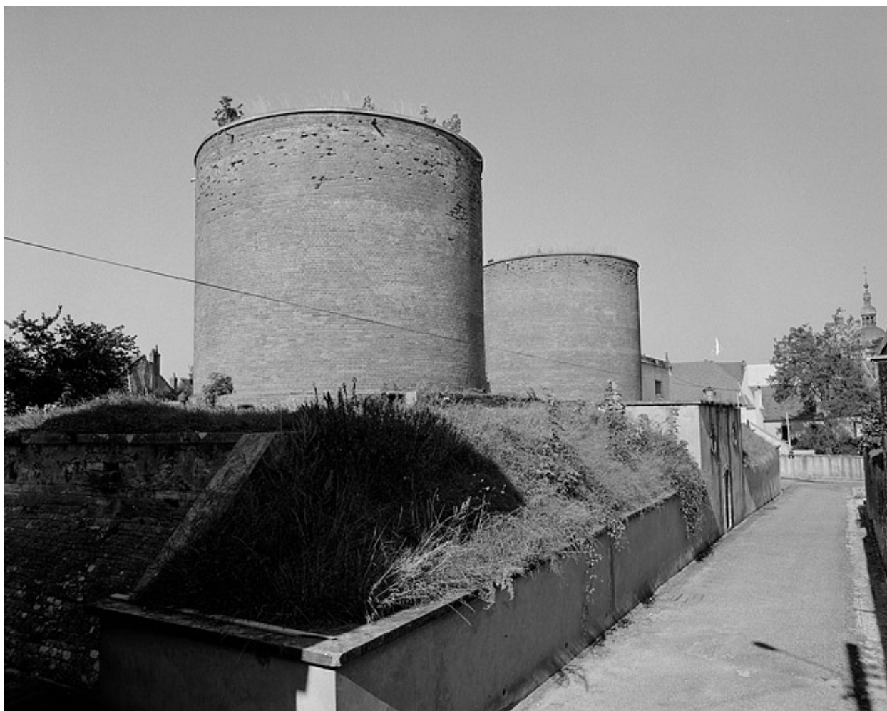
Vue des réservoirs depuis le revers.
