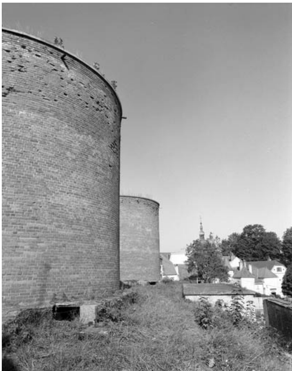
Les réservoirs : vue rapprochée.
