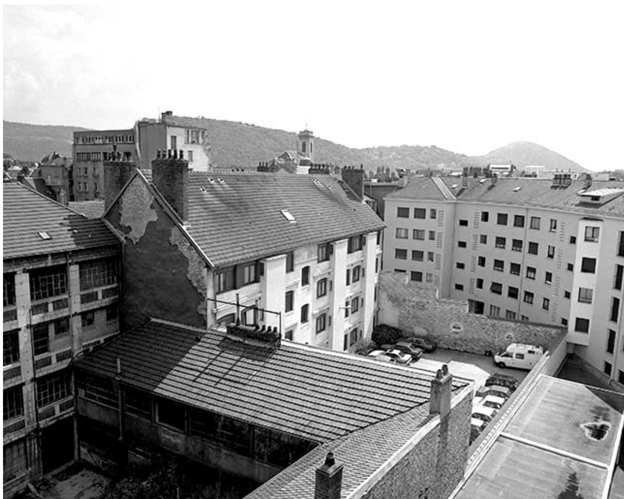
Vue plongeante depuis le nord-est en 1996.
