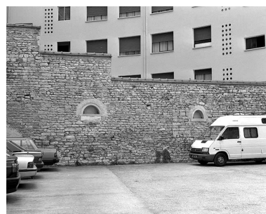
La cour en 1996. Détail du mur de clôture ouest. Phot. Jérôme Mongreville IVR43_19962500133X
