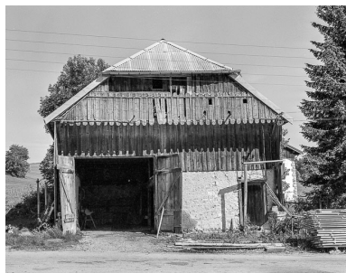
La remise, vue de face. Phot. Dominique Dominguez IVR43_19792500904X
