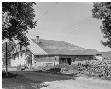
La ferme, vue de trois quarts droit. Phot. Dominique Dominguez IVR43_19792500975X
