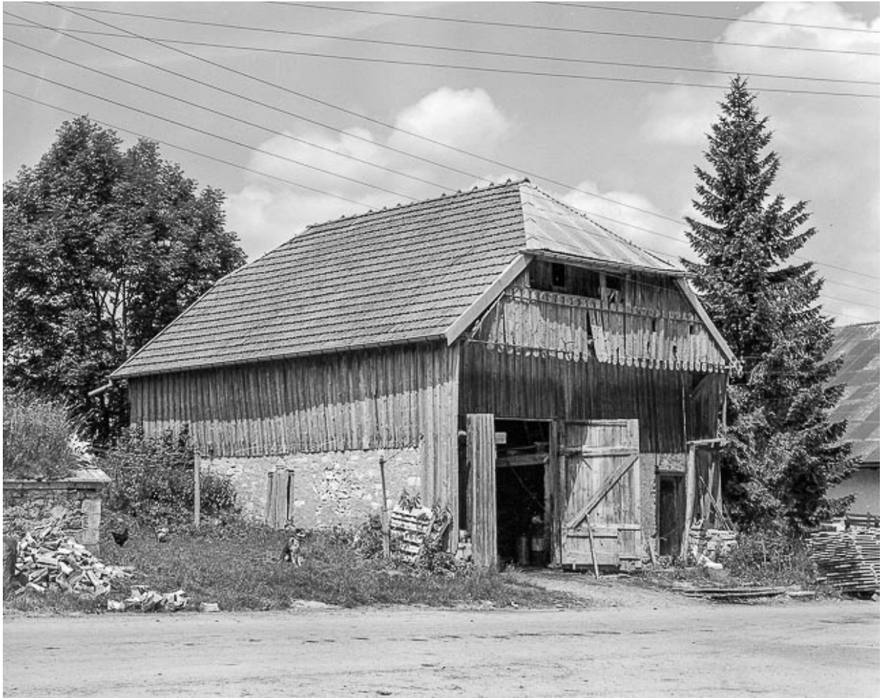
La remise, vue de trois quarts.
