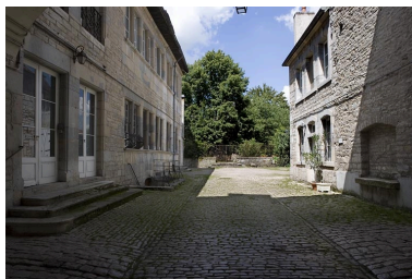
Vue de la cour depuis le portail d'entrée. Phot. Yves Sancey IVR43_20072500744NUCA
