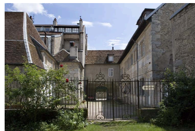
Vue d'ensemble de la cour derrière la grille du jardin. Phot. Yves Sancey IVR43_20072500705NUCA
