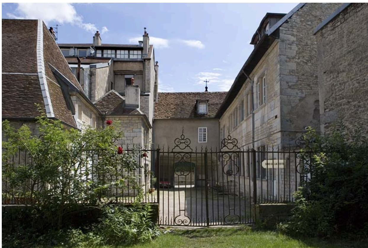
Vue d'ensemble de la cour derrière la grille du jardin.
