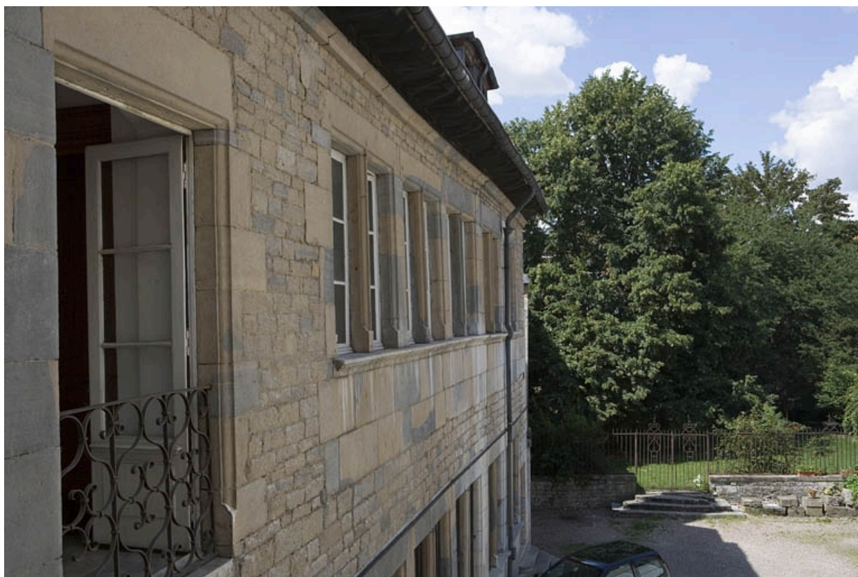
Détail du premier étage de la façade sur cour du logis principal, depuis le premier étage de l'aile d'entrée.
