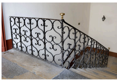
Détail de l'escalier d'honneur depuis le premier étage. Phot. Yves Sancey IVR43_20072500750NUCA
