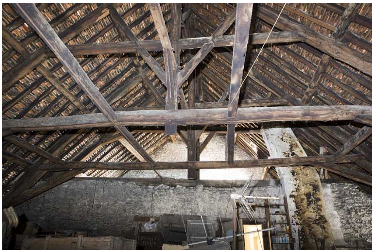
Intérieur, comble : vue de la charpente depuis le fond du grenier, vue rapprochée.
