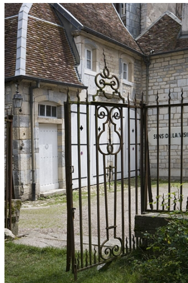
Détail de la porte de la grille du jardin.
