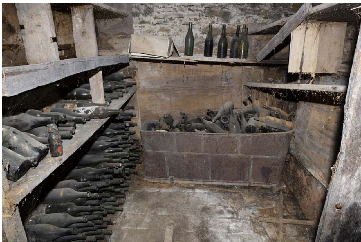
Intérieur, sous-sol : intérieur de la réserve à bouteilles, cave gauche.
