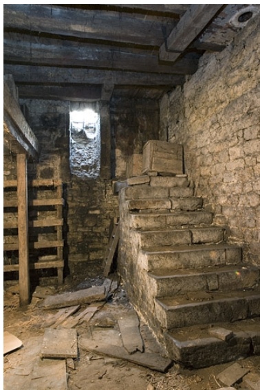
Intérieur, sous-sol : cave droite, partie plafonnée avec l'escalier donnant sur rue. Phot. Yves Sancey IVR43_20072500810NUCA
