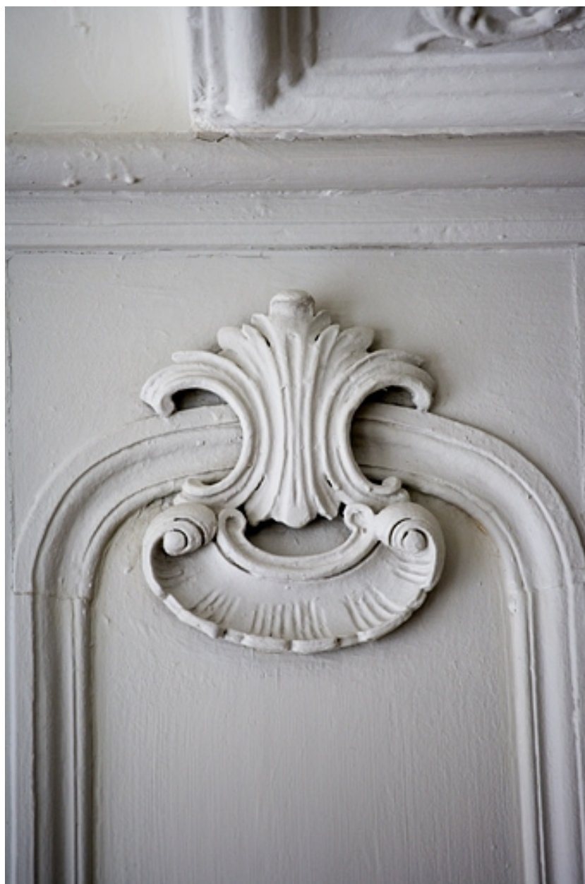
Intérieur, rez-de-chaussée : détail de la partie supérieure d'un petit panneau, lambris du salon.
