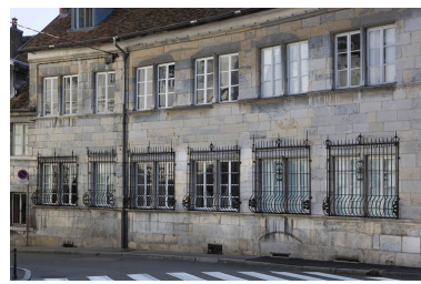
Vue d'ensemble de la façade sur la rue des Martelots. Phot. Yves Sancey IVR43_20072500736NUCA
