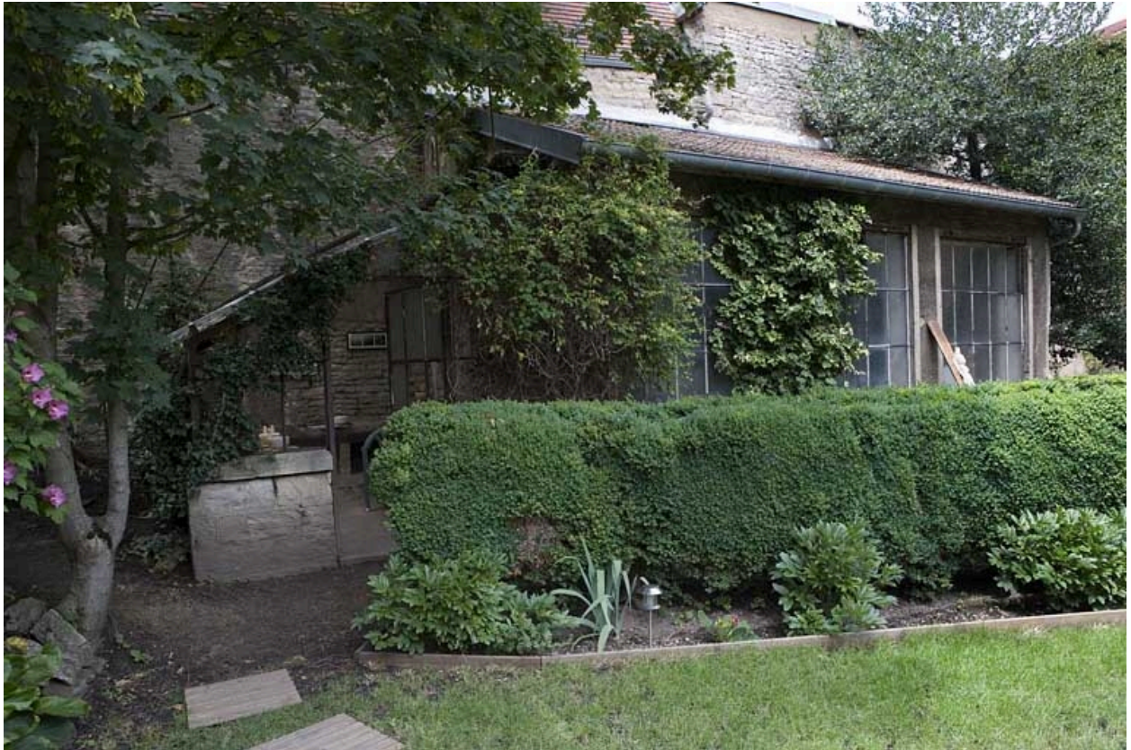
Vue d'ensemble de la serre.
