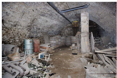
Intérieur, sous-sol : vue de la cave gauche, depuis l'entrée. Phot. Yves Sancey IVR43_20072500799NUCA
