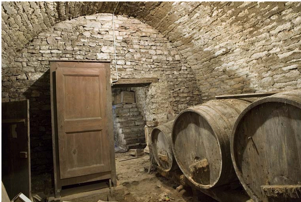
Intérieur, sous-sol : cave droite, partie médiane.
