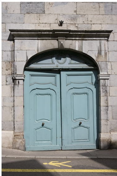
Détail du portail d'entrée sur rue. Phot. Yves Sancey IVR43_20072500820NUCA
