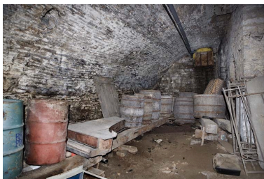
Intérieur, sous-sol : vue de la cave gauche, partie gauche. Phot. Yves Sancey IVR43_20072500800NUCA
