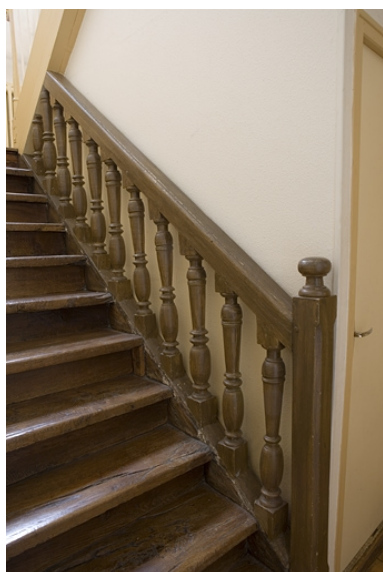
Intérieur, premier étage : détail de l'escalier secondaire conduisant à l'étage de comble. Phot. Yves Sancey IVR43_20072500785NUCA
