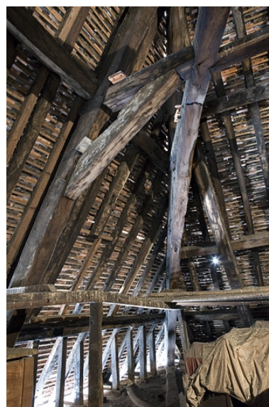
Intérieur, comble : détail de la charpente côté cour. Phot. Yves Sancey IVR43_20072500804NUCA
