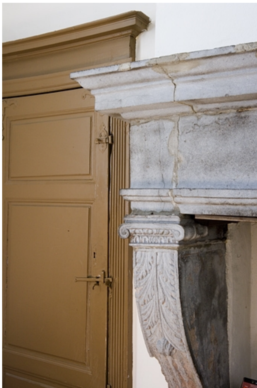
Intérieur, rez-de-chaussée : détail du piedroit gauche de la cheminée de la cuisine.
