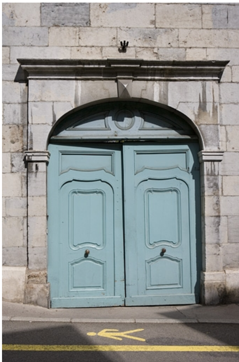
Détail du portail d'entrée sur rue.
