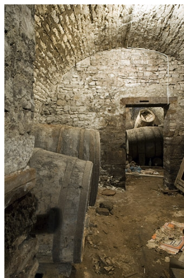
Intérieur, sous-sol : cave droite, partie médiane, vue d'ensemble. Phot. Yves Sancey IVR43_20072500809NUCA
