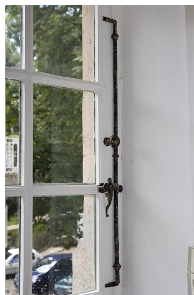
Intérieur, premier étage : détail d'une serrurerie de fenêtre, pièce à droite de l'escalier d'honneur. Phot. Yves Sancey IVR43_20072500788NUCA
