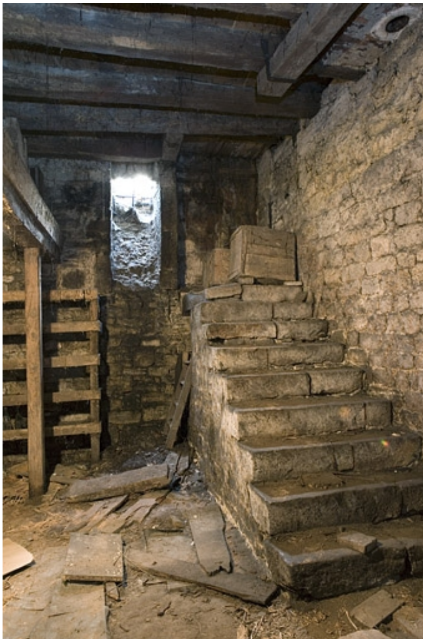
Intérieur, sous-sol : cave droite, partie plafonnée avec l'escalier donnant sur rue.
