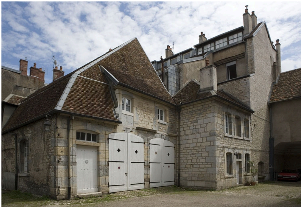
Vue d'ensemble du bâtiment des remises et écurie.
