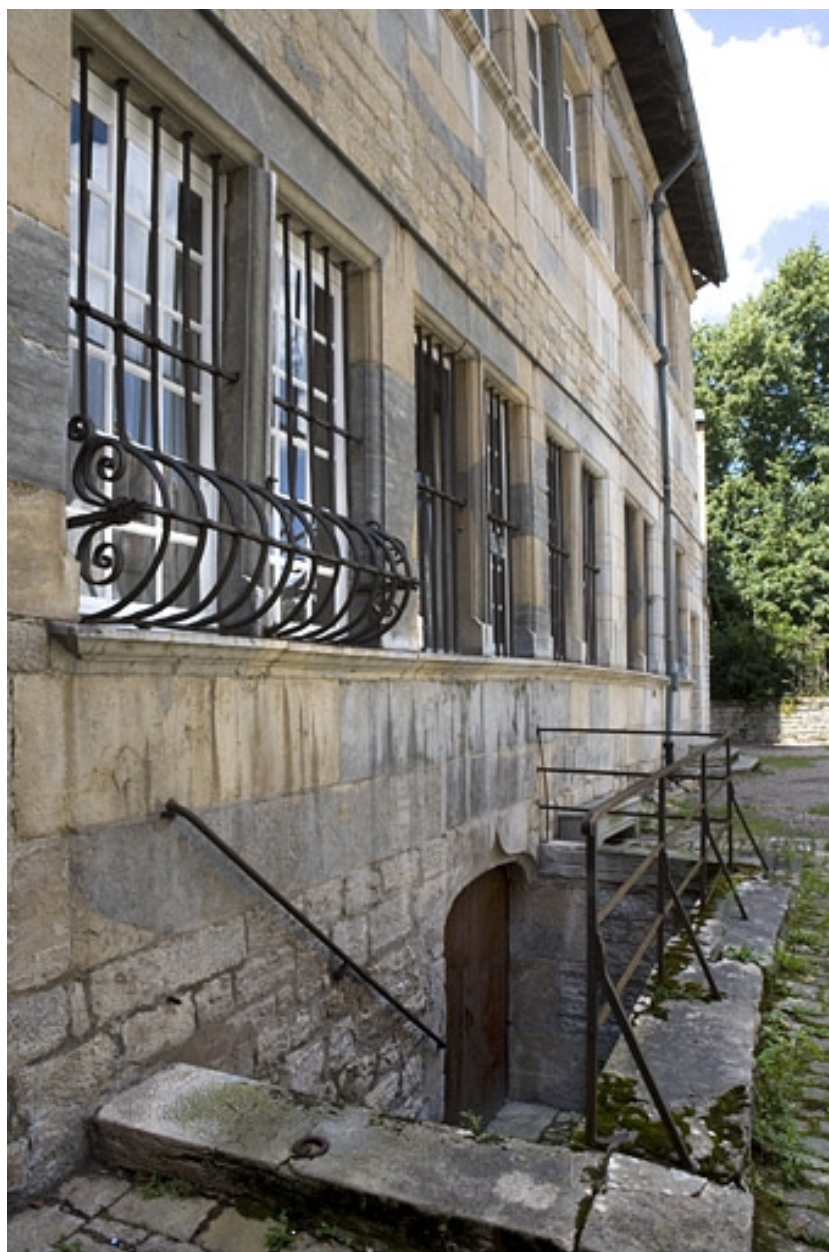
Détail du rez-de-chaussée de la façade sur cour du logis principal.
