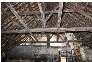
Intérieur, comble : vue de la charpente depuis le fond du grenier, vue rapprochée. Phot. Yves Sancey IVR43_20072500807NUCA
