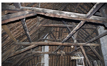
Intérieur, comble : vue de la charpente depuis l'entrée. Phot. Yves Sancey IVR43_20072500803NUCA
