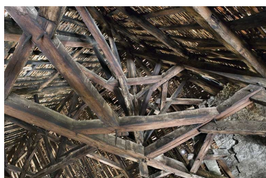
Intérieur, comble : détail des assemblages de la charpente à fermes et croix de Saint-André.
