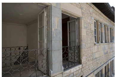
Détail de la cage de l'escalier d'honneur, depuis le premier étage de l'aile d'entrée. Phot. Yves Sancey IVR43_20072500748NUCA
