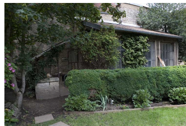
Vue d'ensemble de la serre.
