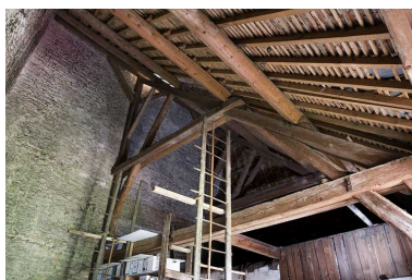
Vue du grenier à foin sur l'écurie.
