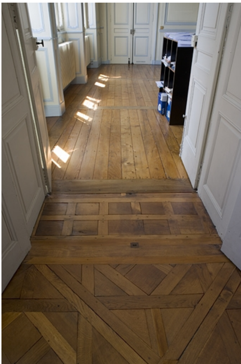
Intérieur, premier étage : détail des planchers de la bibliothèque et de l'antichambre.
