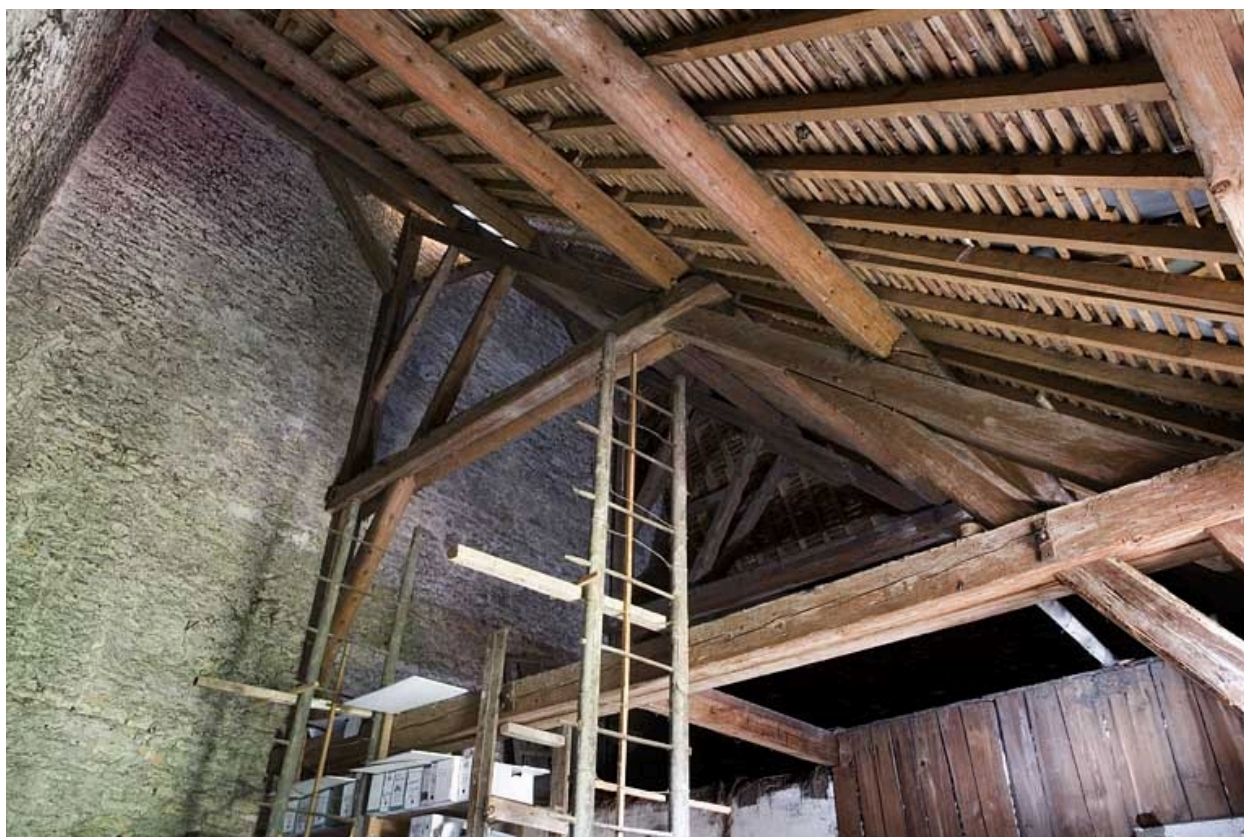
Vue du grenier à foin sur l'écurie.
