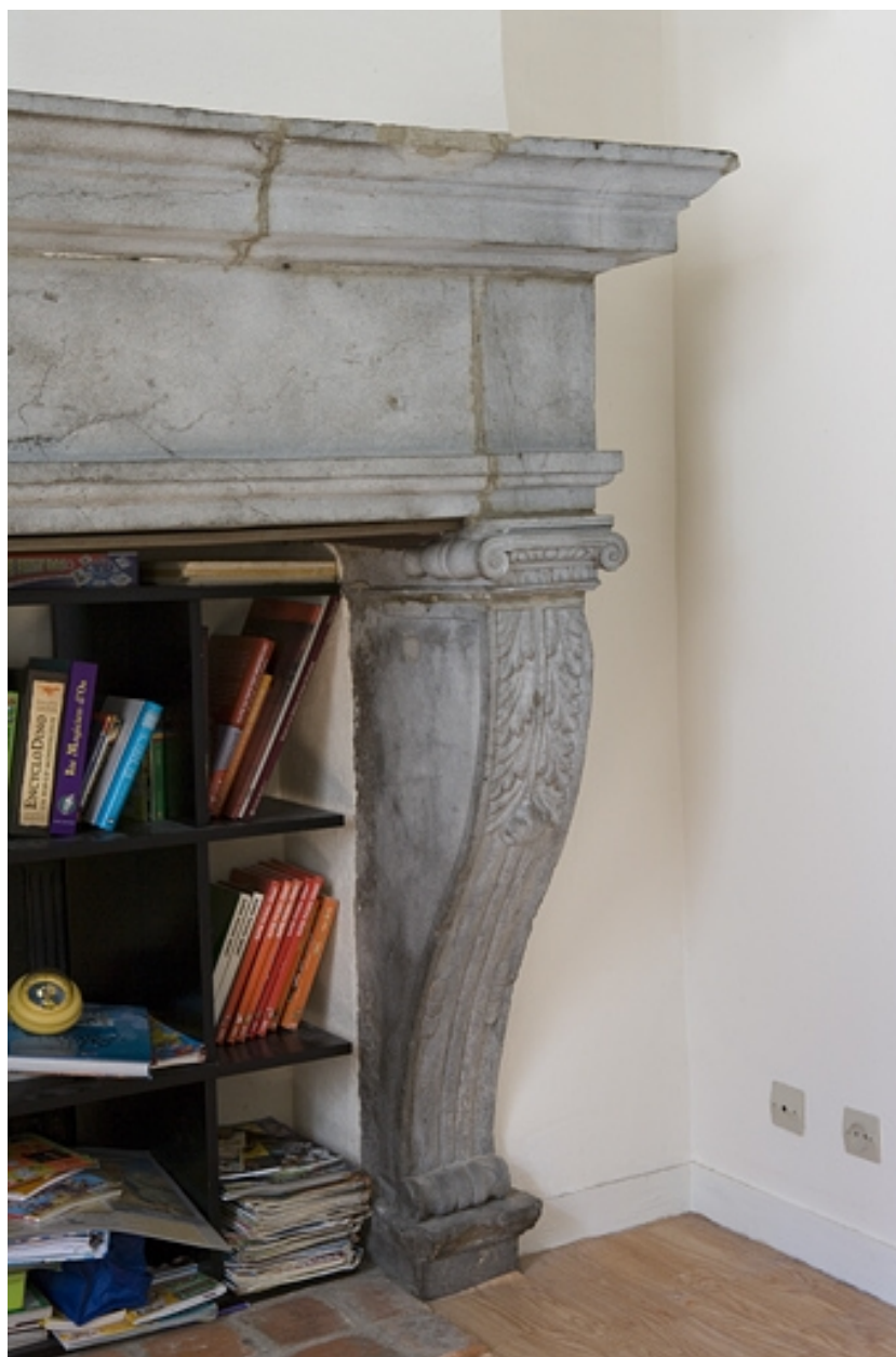
Intérieur, rez-de-chaussée : détail de la partie droite de la cheminée de la cuisine.
