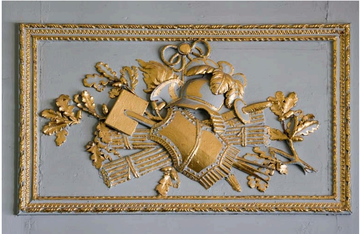
Intérieur, rez-de-chaussée : détail d'un dessus de porte, chambre sur cour.
