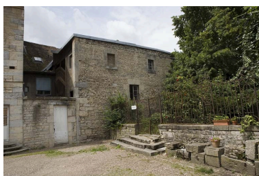
Vue de la grille du jardin de trois quarts droit.
