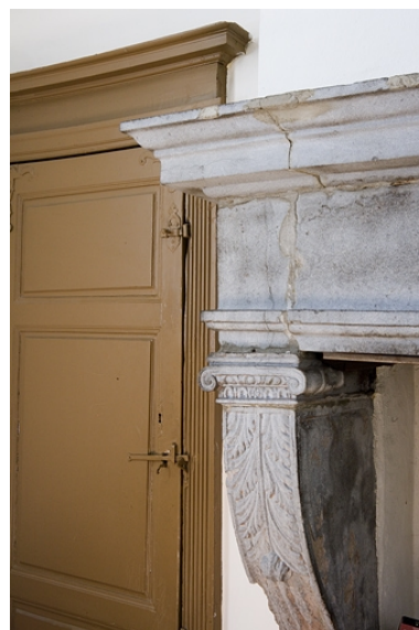
Intérieur, rez-de-chaussée : détail du piedroit gauche de la cheminée de la cuisine. Phot. Yves Sancey IVR43_20072500816NUCA
