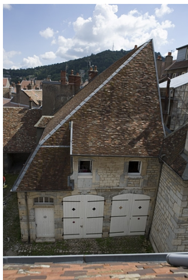
Vue du bâtiment des remises depuis le comble du logis.
