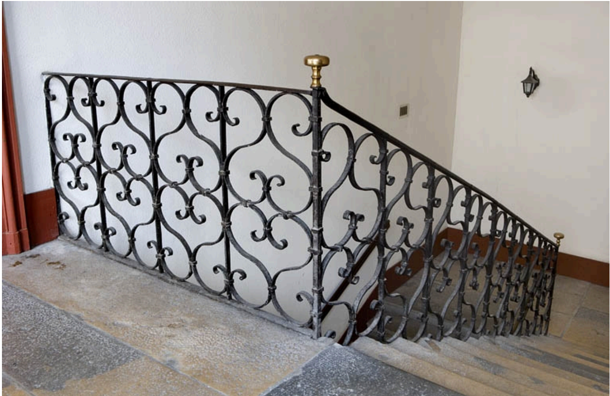
Détail de l'escalier d'honneur depuis le premier étage.
