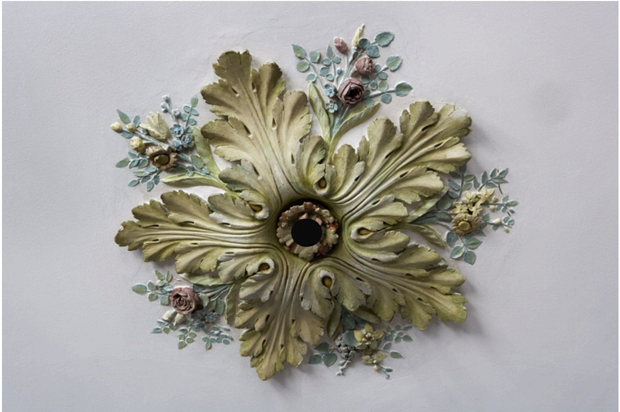
Intérieur, premier étage : détail de la rosace du plafond.
