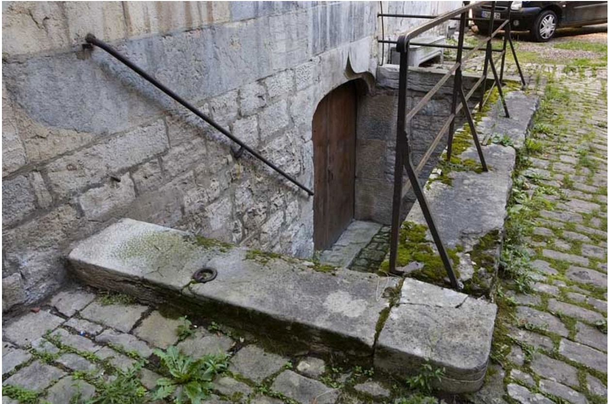
Logis principal : détail de l'entrée du sous-sol.
