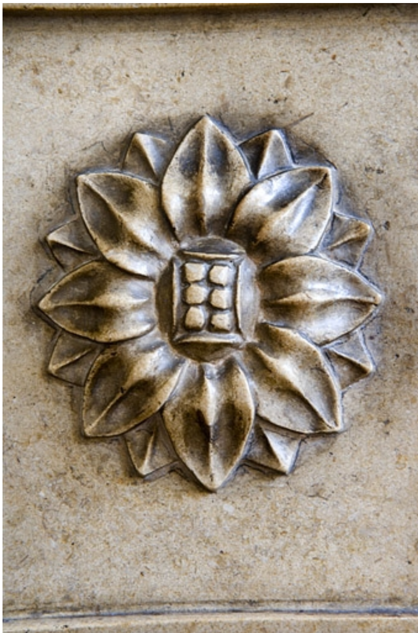
Intérieur, premier étage : détail de la rosace ornant les piédroits de la cheminée de la bibliothèque.
