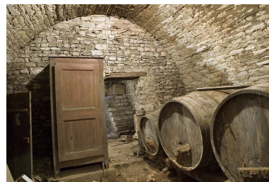
Intérieur, sous-sol : cave droite, partie médiane. Phot. Yves Sancey IVR43_20072500812NUCA
