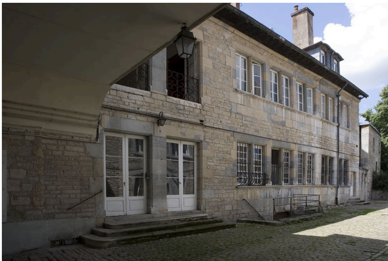
Vue de la façade sur cour du logis principal depuis le portail d'entrée.
