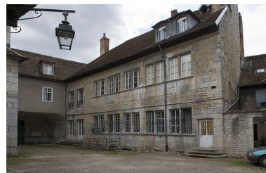
Vue d'ensemble d'ensemble du logis principal depuis le fond de la cour. Phot. Yves Sancey IVR43_20072500707NUCA
