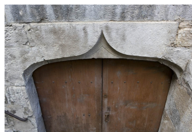
Détail de l'entrée du sous-sol sur cour. Phot. Yves Sancey IVR43_20072500813NUCA
