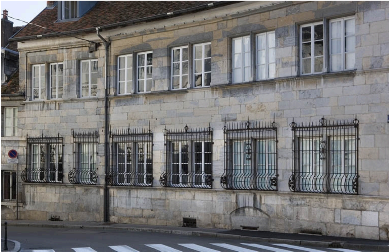
Vue d'ensemble de la façade sur la rue des Martelots.
