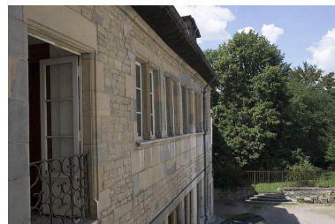
Détail du premier étage de la façade sur cour du logis principal, depuis le premier étage de l'aile d'entrée. Phot. Yves Sancey IVR43_20072500747NUCA
