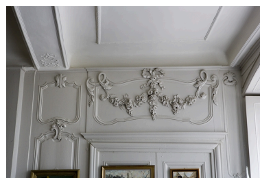
Intérieur, rez-de-chaussée : détail de la partie supérieure de deux lambris du salon.
