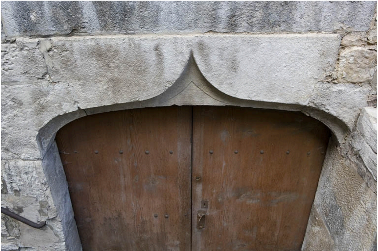
Détail de l'entrée du sous-sol sur cour.
