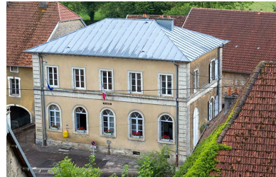
Vue rapprochée depuis le château. Phot. Jérôme Mongreville IVR43_20167000712NUC4A
