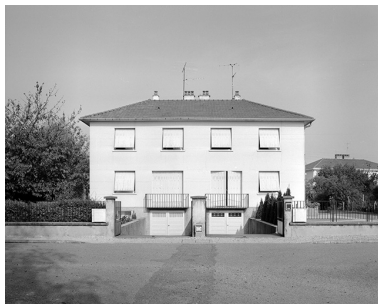
Façade antérieure, vue de face.
