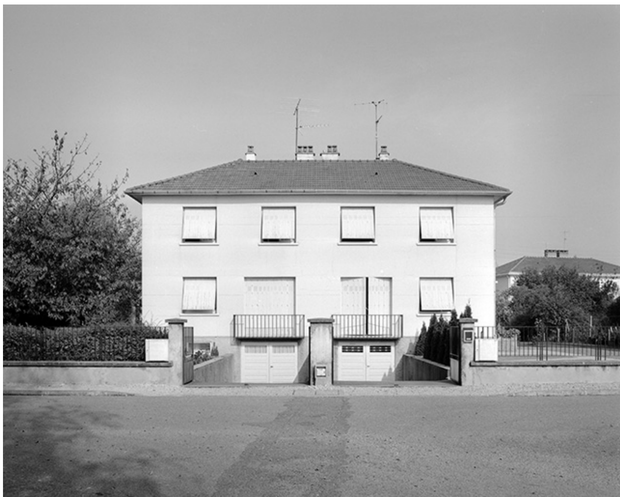
Façade antérieure, vue de face.
