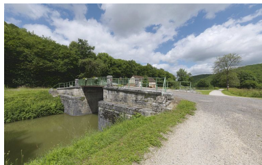
Pont vu de l'aval. Phot. Thierry Kuntz IVR26_20122102298NUC4A
