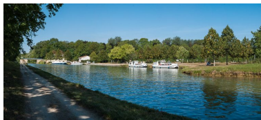
Vue d'ensemble du port.
