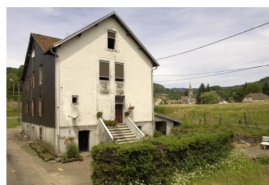
Logements de contremaître. Phot. Jérôme Mongreville IVR43_20057000298NUCA
