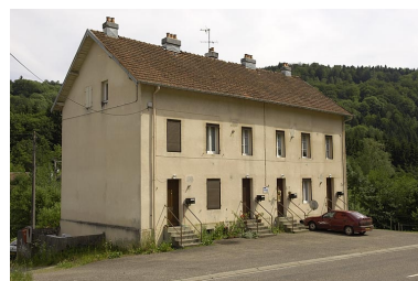
Logement ouvrier collectif. Phot. Jérôme Mongreville IVR43_20057000307NUCA
