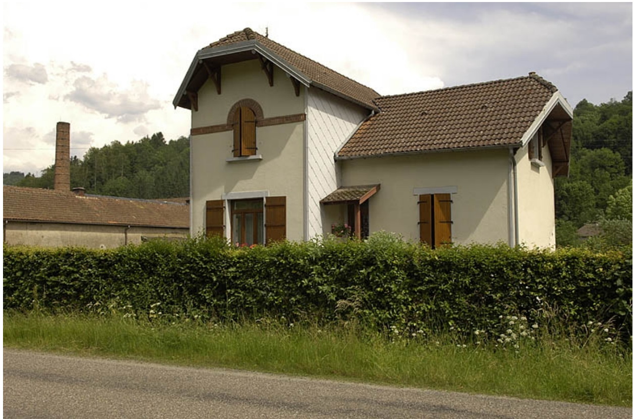
Logement de contremaître.
