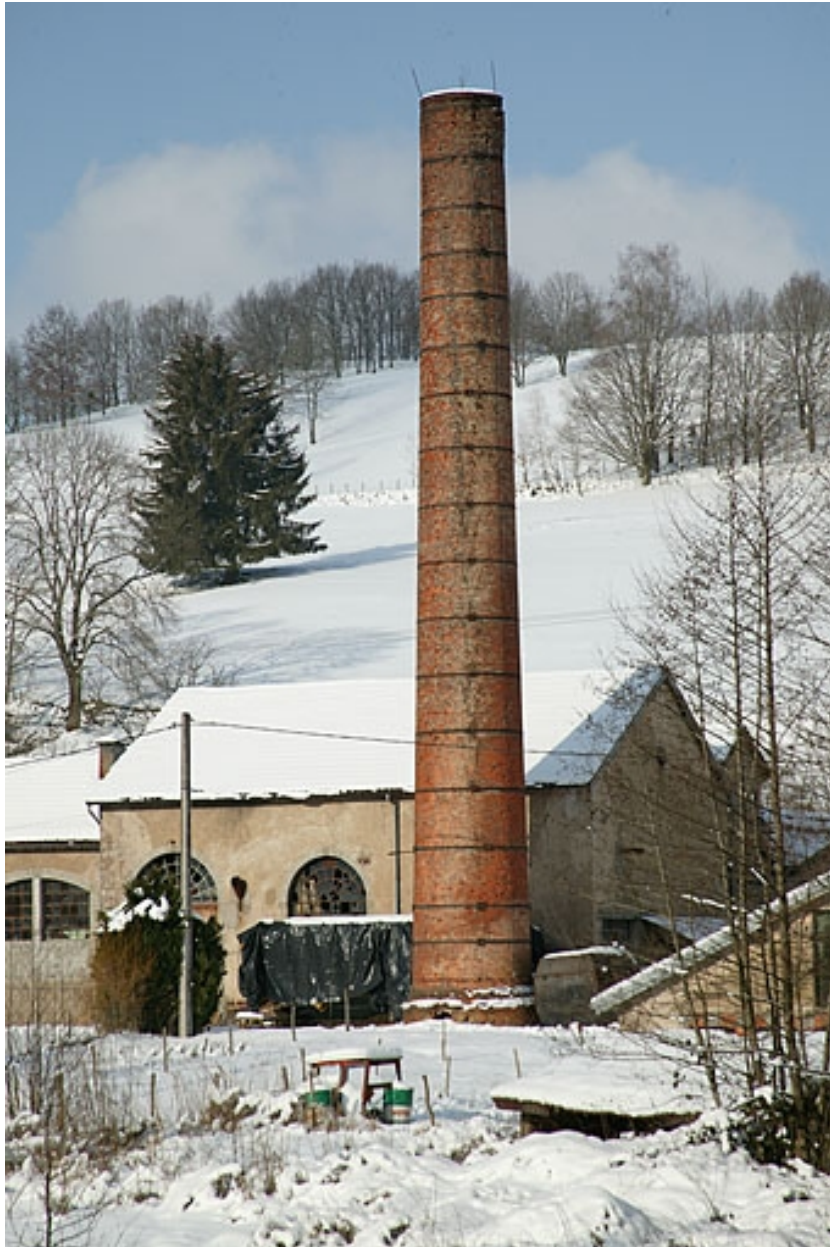
Salle des machines et sa cheminée.
