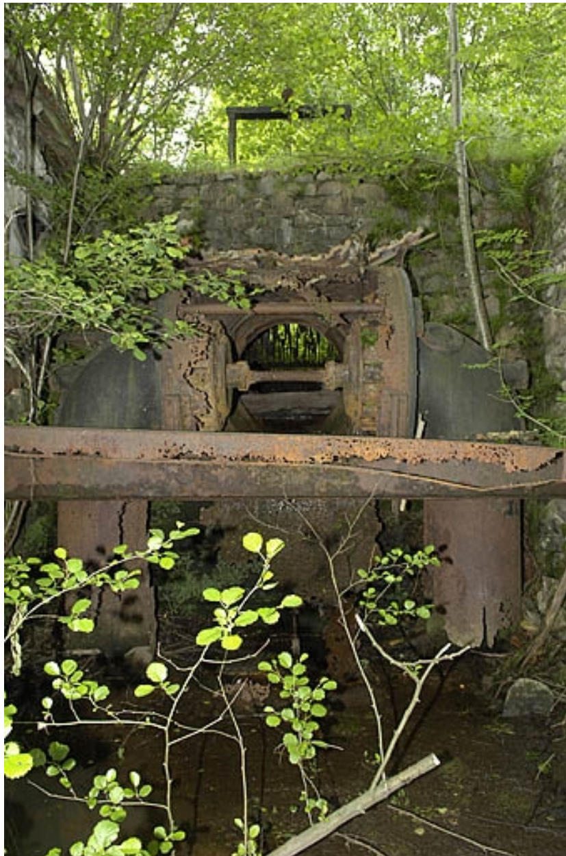
Vue d'ensemble de la turbine hydraulique.
