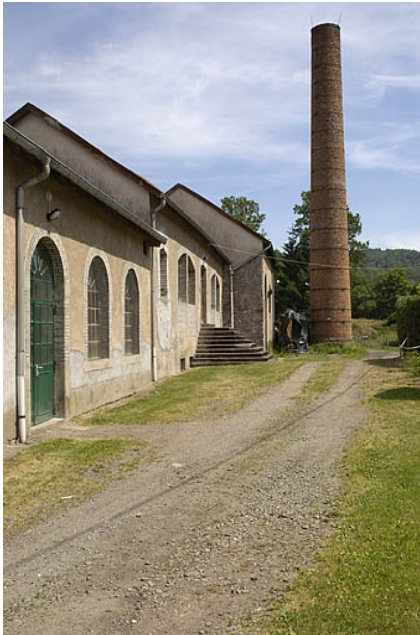
Alignement des façades postérieures.
