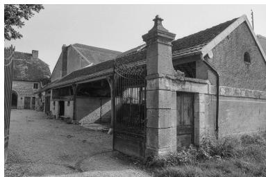
Remise sur le côté droit de la cour. Phot. Dominique Dominguez IVR43_19807000377Z
