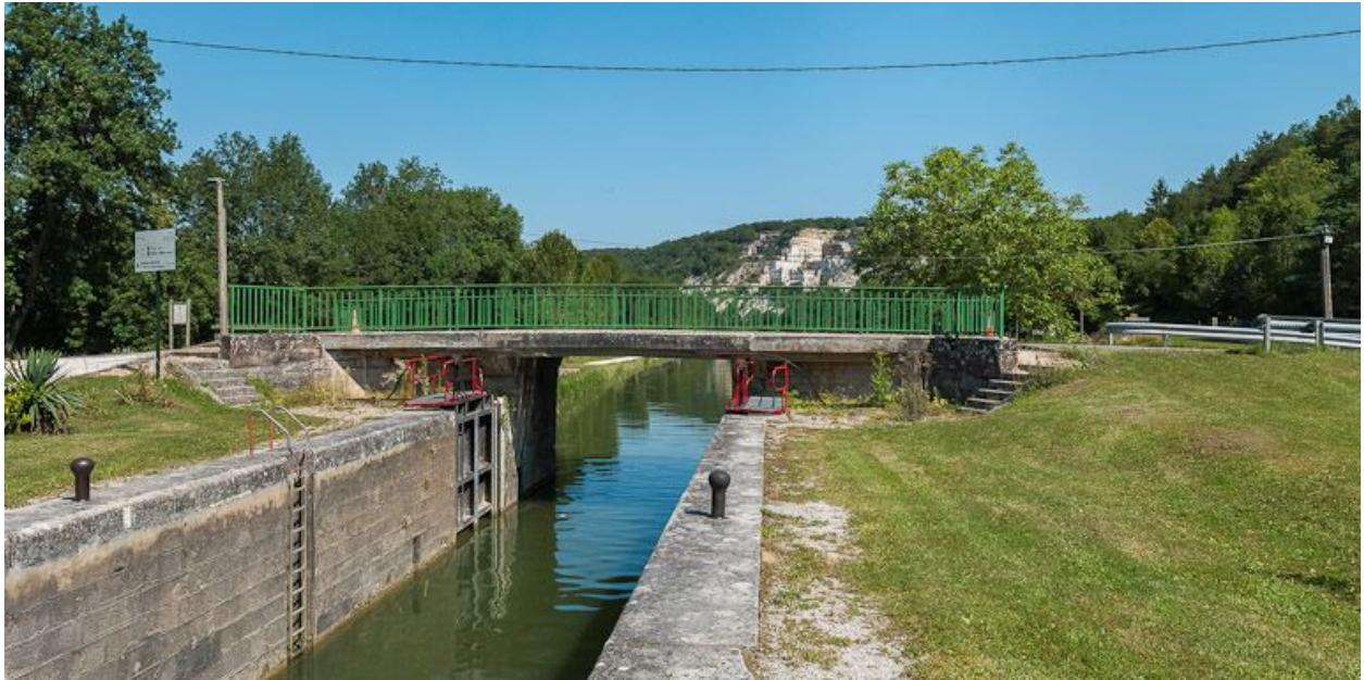
Le pont vu du sas.
