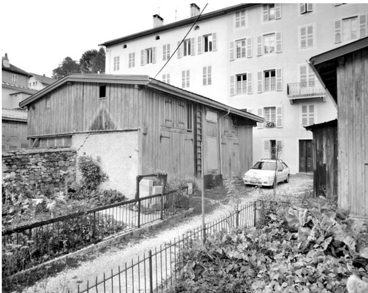
Bâtiment sud : bûcher et garage.
