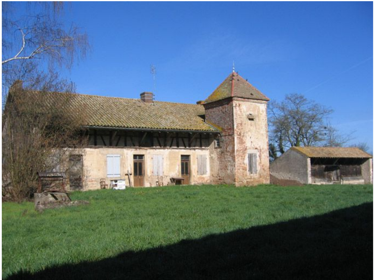
Vue d'ensemble de la façade de l'habitation.
