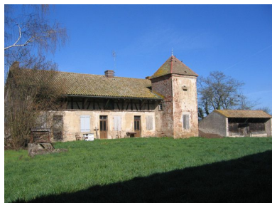
Vue d'ensemble de la façade de l'habitation.
