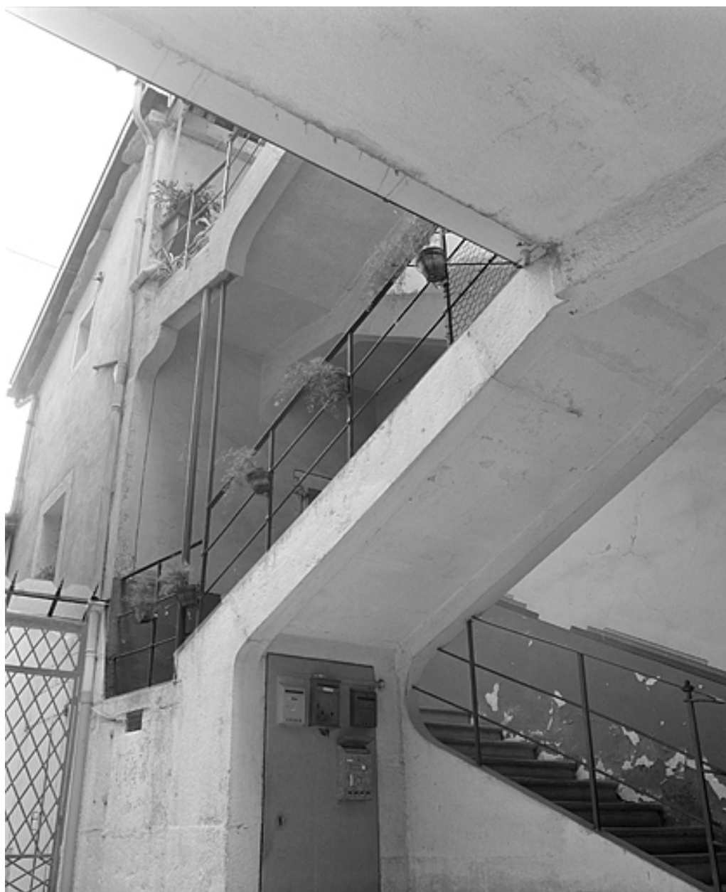
L'escalier ouvrant sur la cour.
