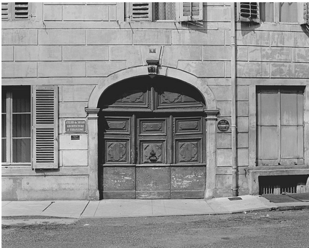
Portail de la façade antérieure.
