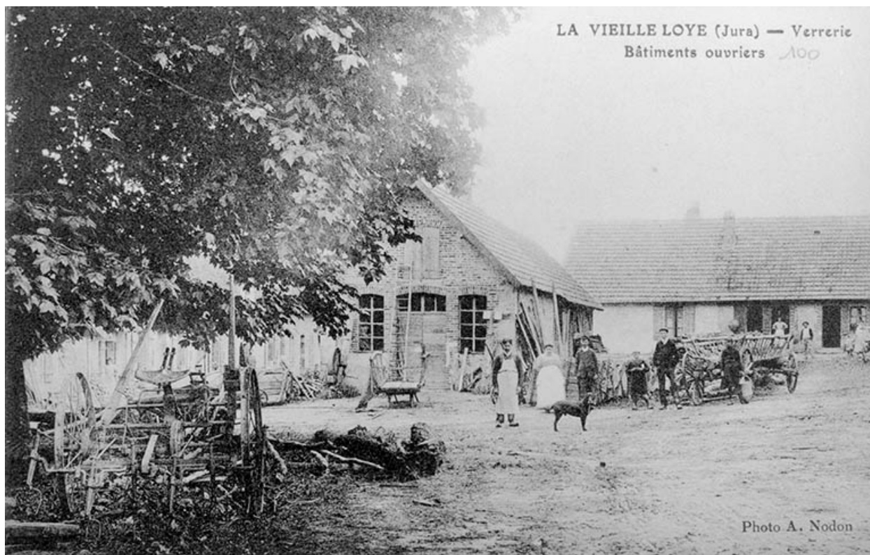
La Vieille-Loye (Jura) - Verrerie. Bâtiments ouvriers.
