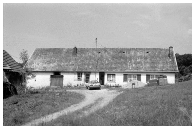
Logement d'ouvriers (E). Phot. Laurent Poupard IVR43_19883900471Z
