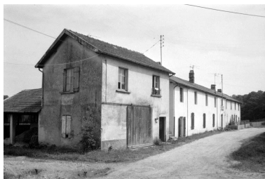
Logements d'ouvriers (C) et (D). Phot. Laurent Poupard IVR43_19883900469Z
