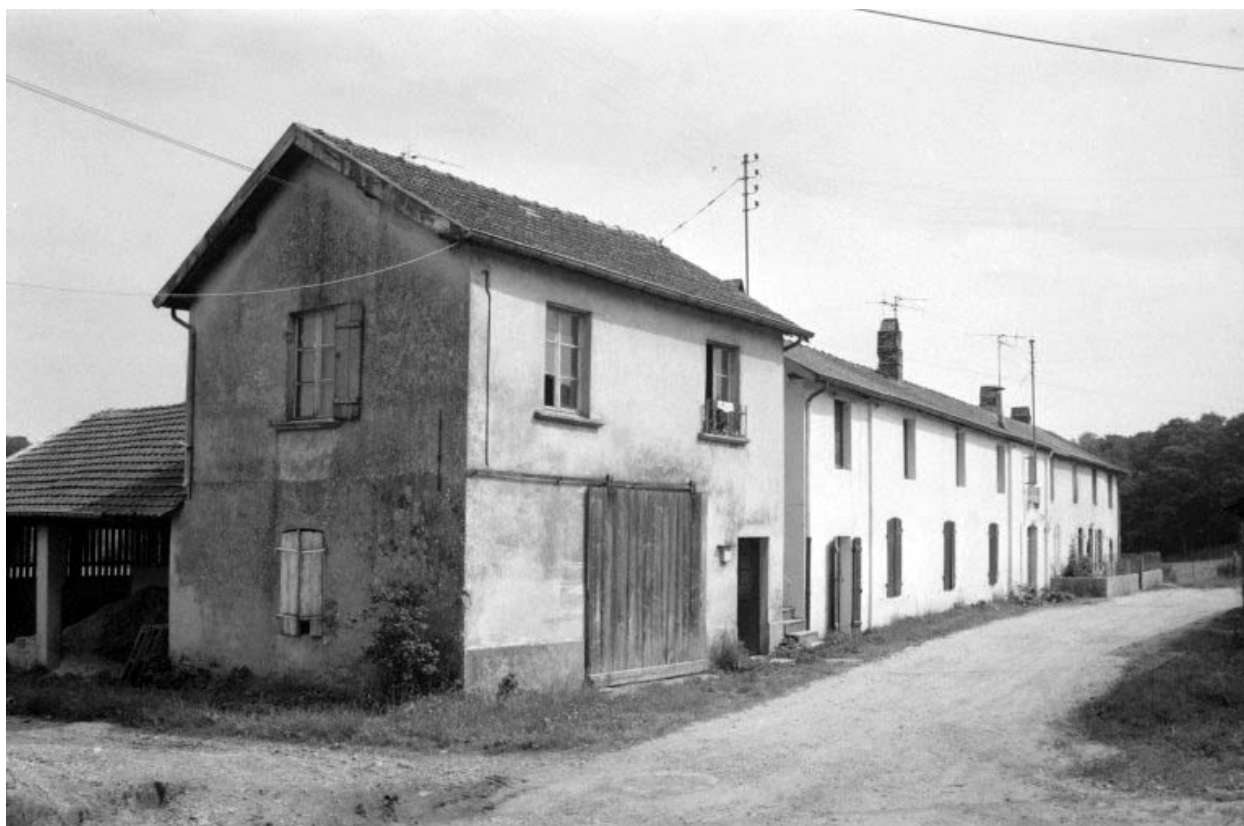
Logements d'ouvriers (C) et (D).
