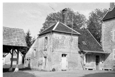
Pavillon nord du logement patronal. Phot. Laurent Poupard IVR43_19883900467Z
