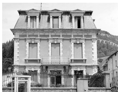
Elévation latérale gauche (vue rapprochée). Phot. Yves Sancey IVR43 20033900109X
