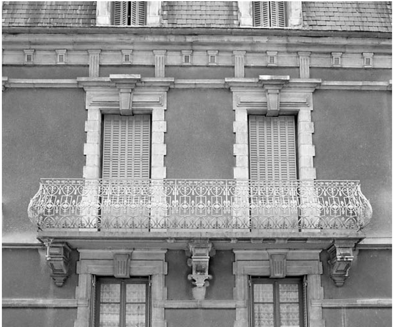
Elévation antérieure : balcon.
