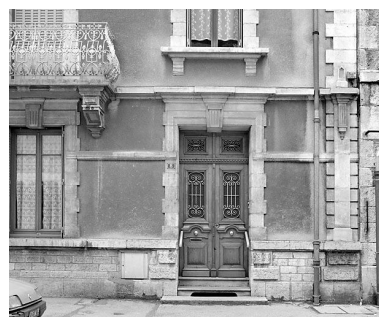
Elévation antérieure : porte. Phot. Yves Sancey IVR43 20033900113X
