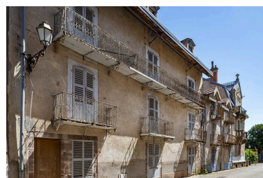
Façade sur l'allée des Romains, vue de trois quarts depuis le nord. Phot. Jérôme Mongreville IVR43_20207000556NUC4A
