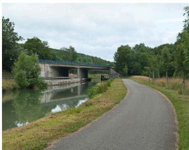
Vue d'ensemble du pont.
