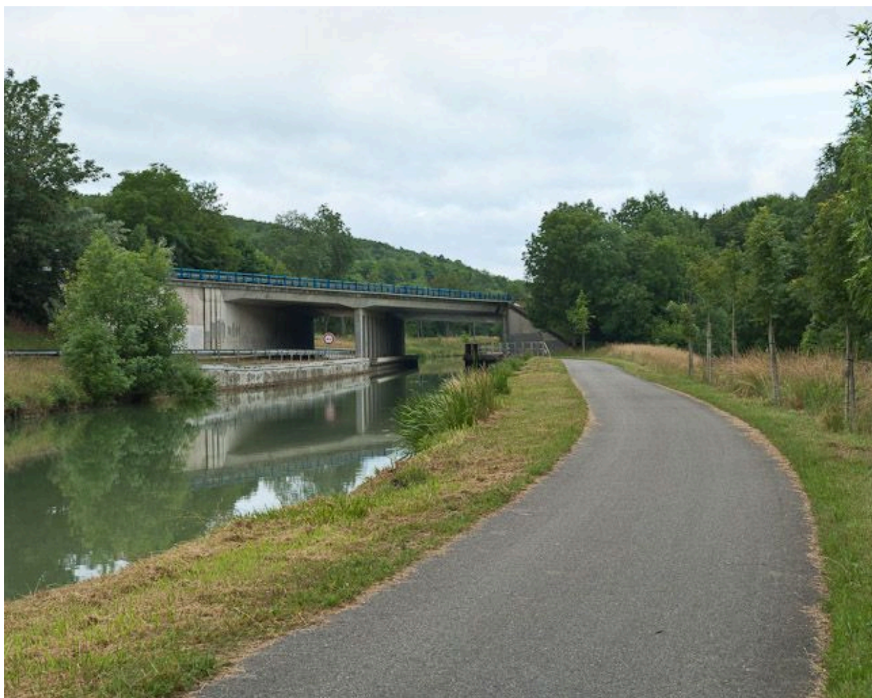
Vue d'ensemble du pont.
