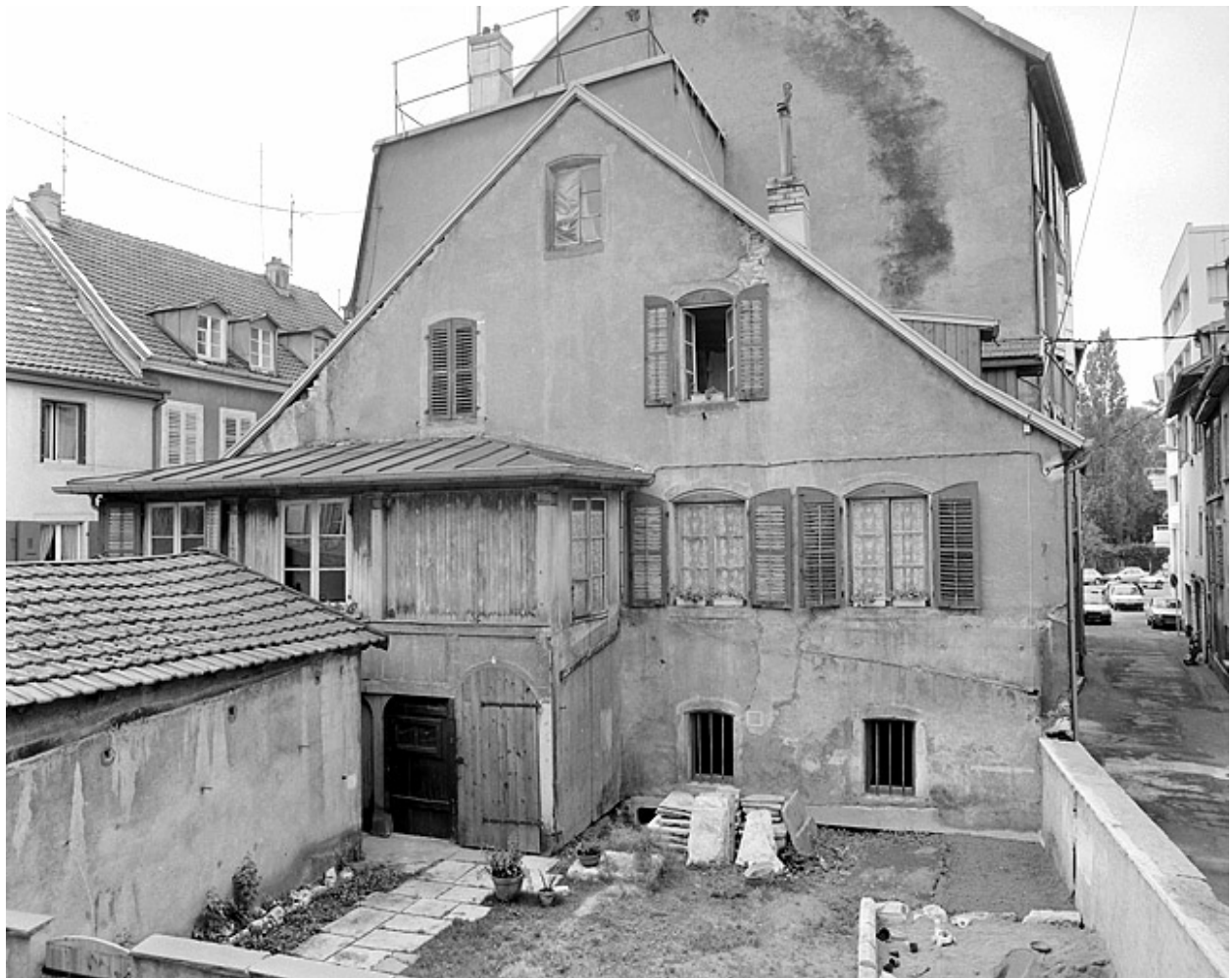
Façade sur cour.
