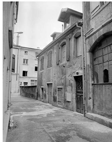
Façade sur la rue des Tanneries. Phot. Jérôme Mongreville IVR43_19872500636X
