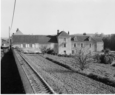
Elévation postérieure. Phot. non renseigné IVR26_19728900228X
