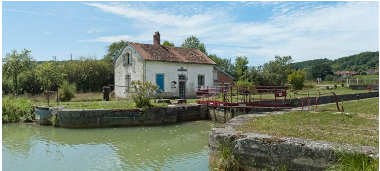
Vue d'ensemble du site d'écluse.
