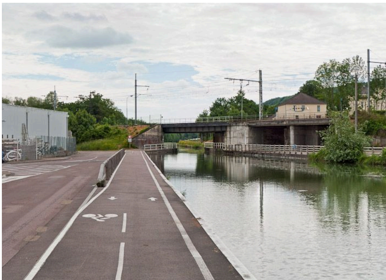
Vue d'ensemble du pont.
