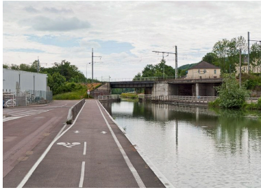
Vue d'ensemble du pont.
