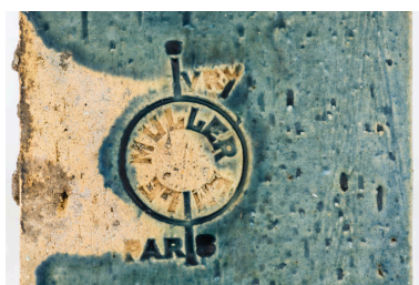
Décor de céramique de l'entablement, détail : marque d'Émile Müller à Ivry-Paris. Phot. Pierre-Marie Barbe-Richaud IVR26_20245800186NUC4A
