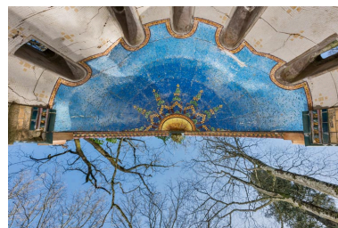
Voûte de l'abside. Phot. Pierre-Marie Barbe-Richaud IVR26_20245800169NUC4A
