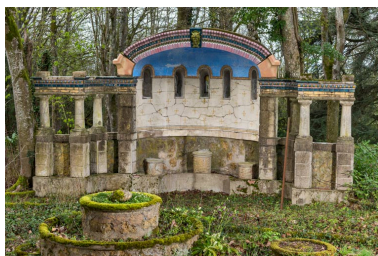
Face principale (vue de face). Phot. Pierre-Marie Barbe-Richaud IVR26_20245800172NUC4A
