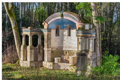
Face principale (vue de trois quarts). Phot. Pierre-Marie Barbe-Richaud IVR26_20245800165NUC4A
