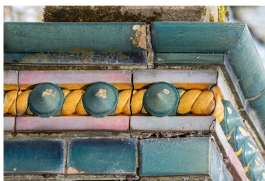
Décor de céramique de l'entablement, détail : frise (corde et cabochons). Phot. Pierre-Marie Barbe-Richaud IVR26_20245800171NUC4A
