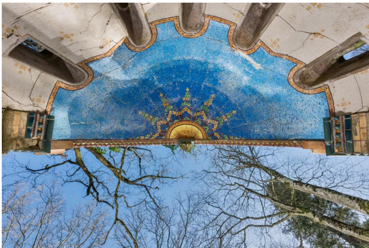
Voûte de l'abside.
