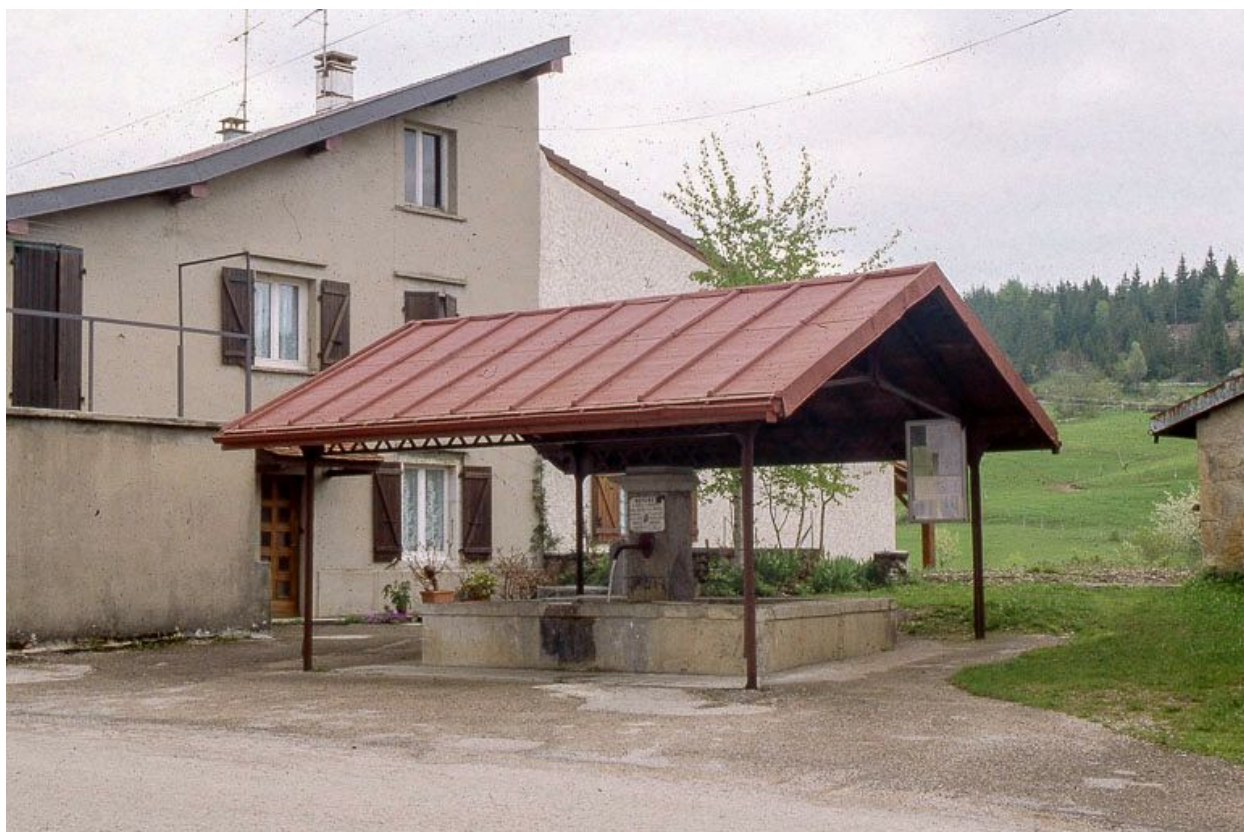
Fontaine située rue Bourgeat-d'Amont.
