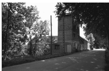
Façade sur rue. Phot. Bernard Lardière IVR43_19817000832Z
