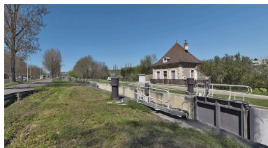
Vue d'ensemble du site d'écluse (d'aval).
