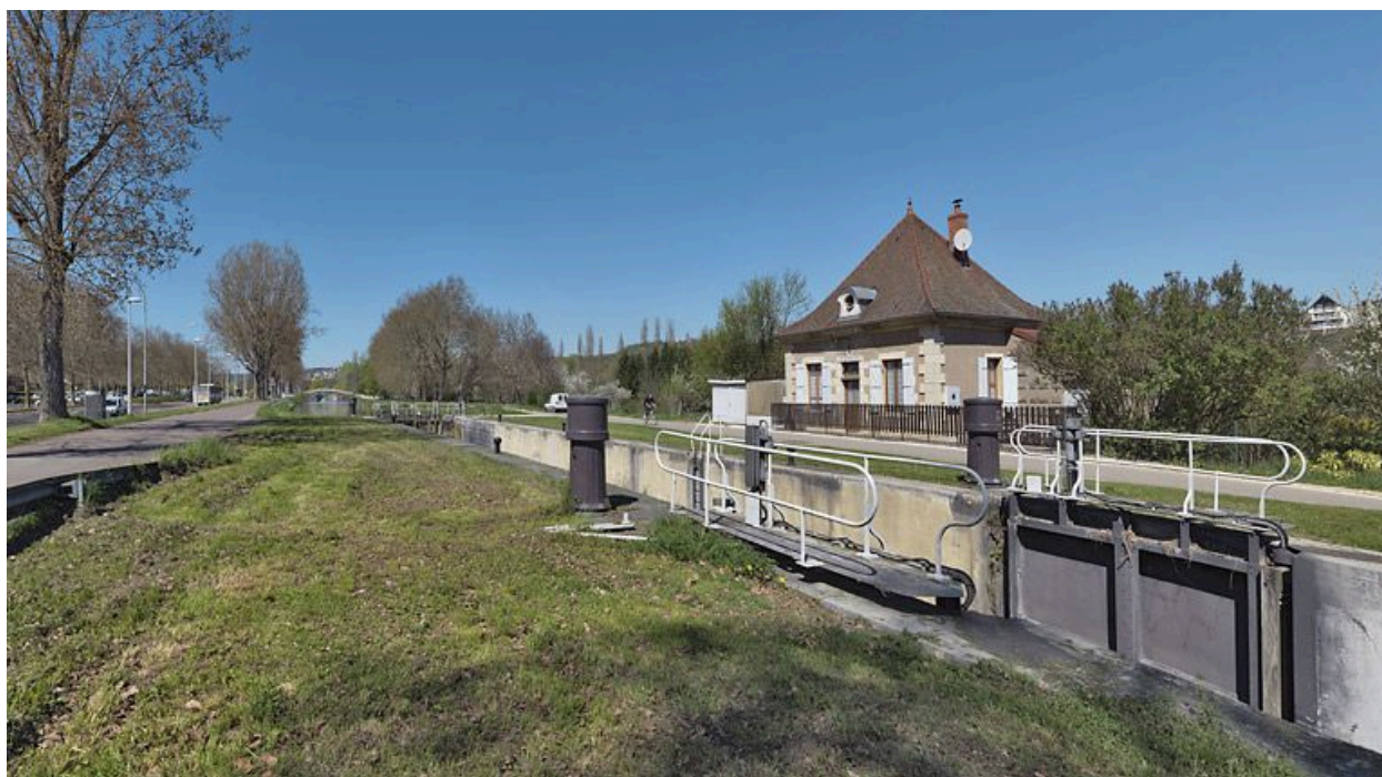
Vue d'ensemble du site d'écluse (d'aval).
