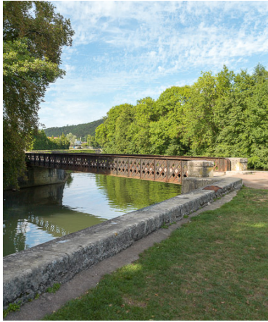
VUe du pont.
