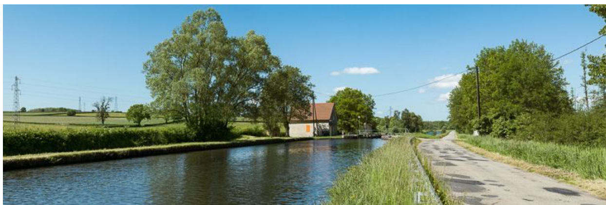
Vue d'ensemble du site, prise d'amont.
