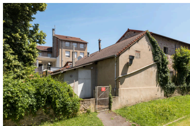
Façade postérieure, de trois quarts gauche. Phot. Pierre-Marie Barbe-Richaud IVR26_20257100743NUC4A
