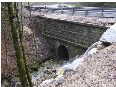
Vue générale sur l'ouvrage. Phot. Anne-Laure Madinier IVR43_20083900605NUC1A
