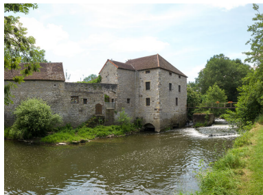
Vue du moulin sur la Bourbince. Phot. Pierre-Marie Barbe-Richaud IVR26_20137100474NUC4AQ
