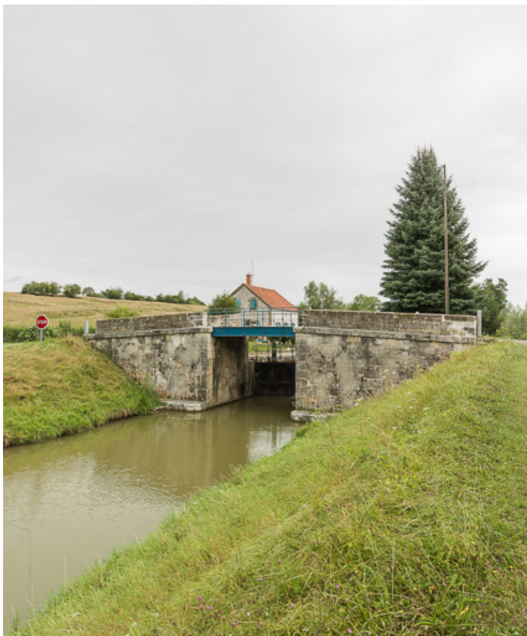
Vue d'ensemble du pont.
