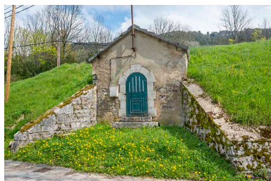
Réservoir de Chambenoz (1910). Côté ouest. Phot. Jérôme Mongreville IVR43_20233900261NUC4A
