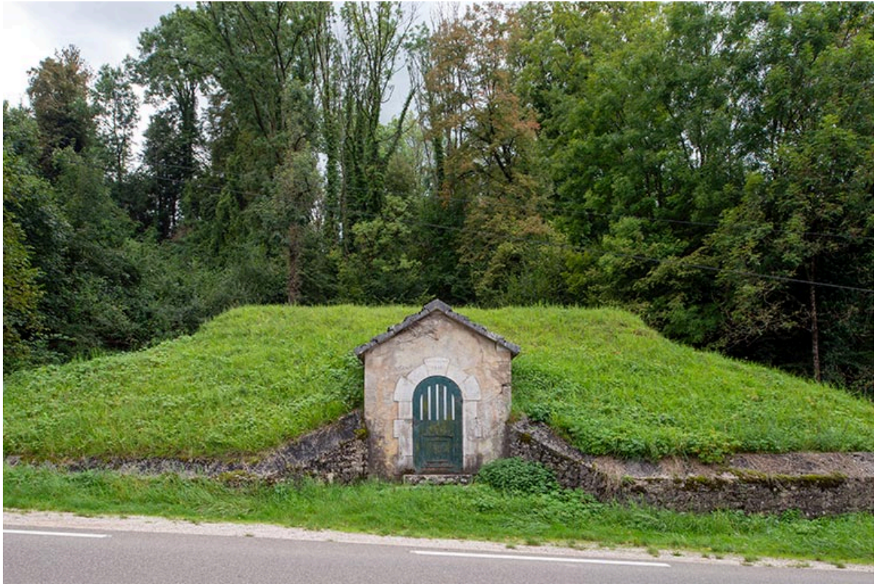
Réservoir de Veley (1910). Vue de face.
