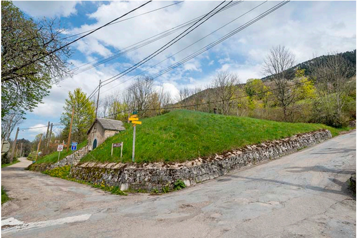
Réservoir de Chambenois (1910), chemin de la Plaine. Vue d'ensemble depuis le sud-ouest.
