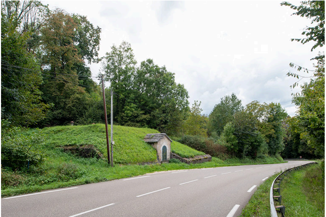
Réservoir de Veley (1910), R.D. 472. Vue depuis l'est.
