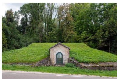
Réservoir de Veley (1910). Vue de face. Phot. Nicolas Waltefaugle IVR43_20253900258NUC4A
