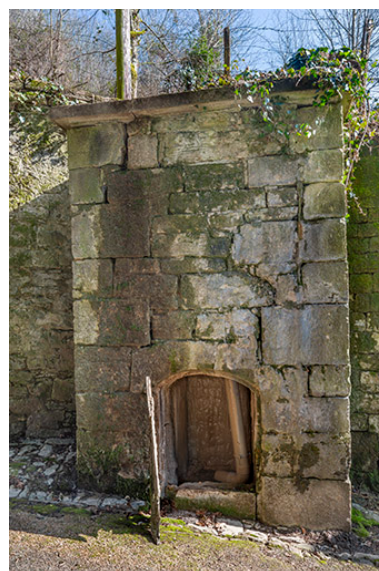
Escalier de Saint-Anatoile. Vue rapprochée du captage. Phot. Jérôme Mongreville IVR43_20243901119NUC4A
