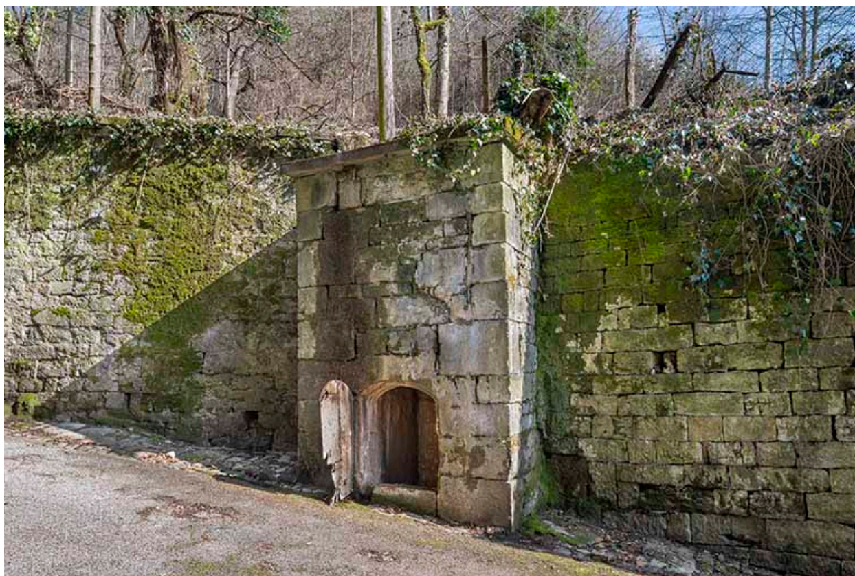
Escalier de Saint-Anatoile. Captage d'une source.
