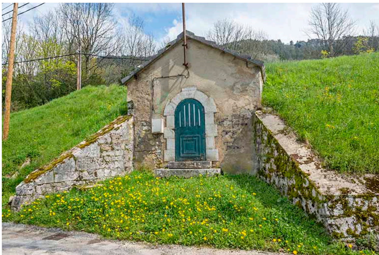
Réservoir de Chambenoz (1910). Côté ouest.
