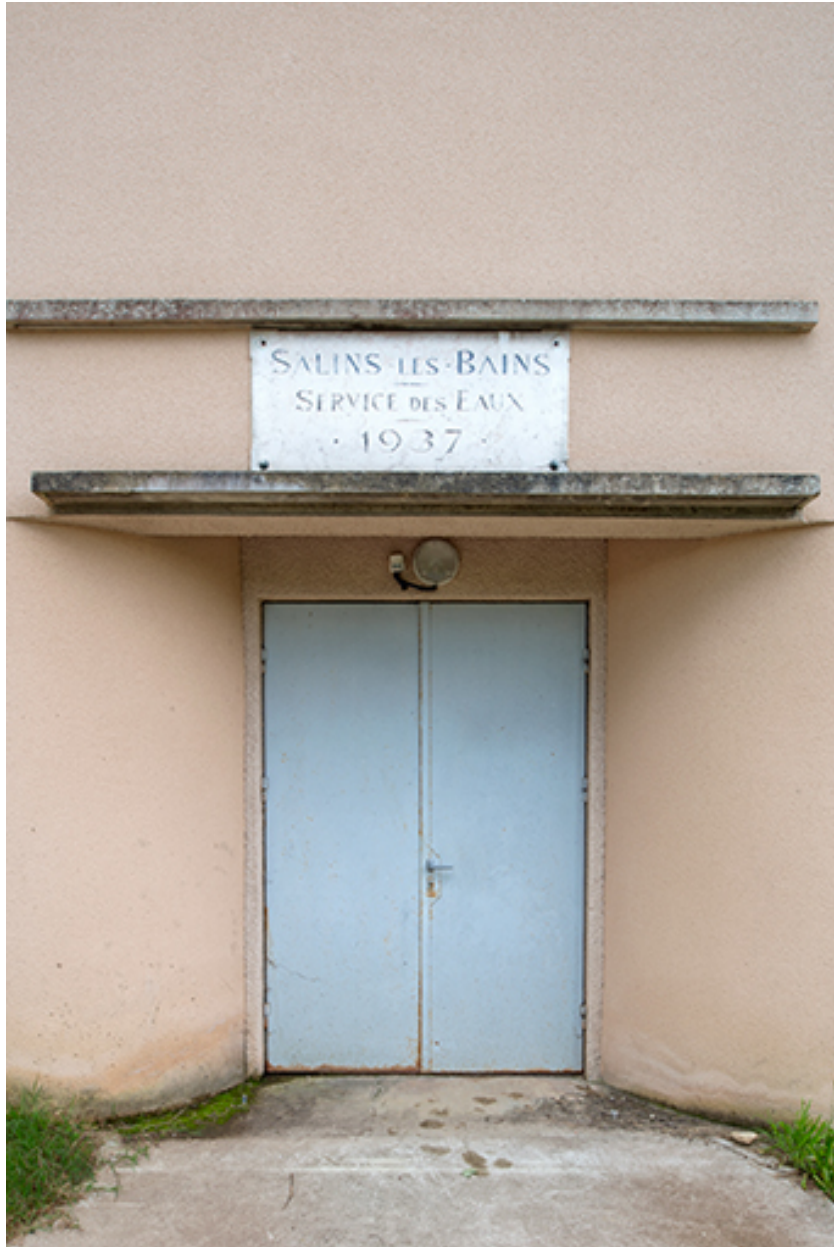
Station de stérilisation (1937). Détail de la porte.
