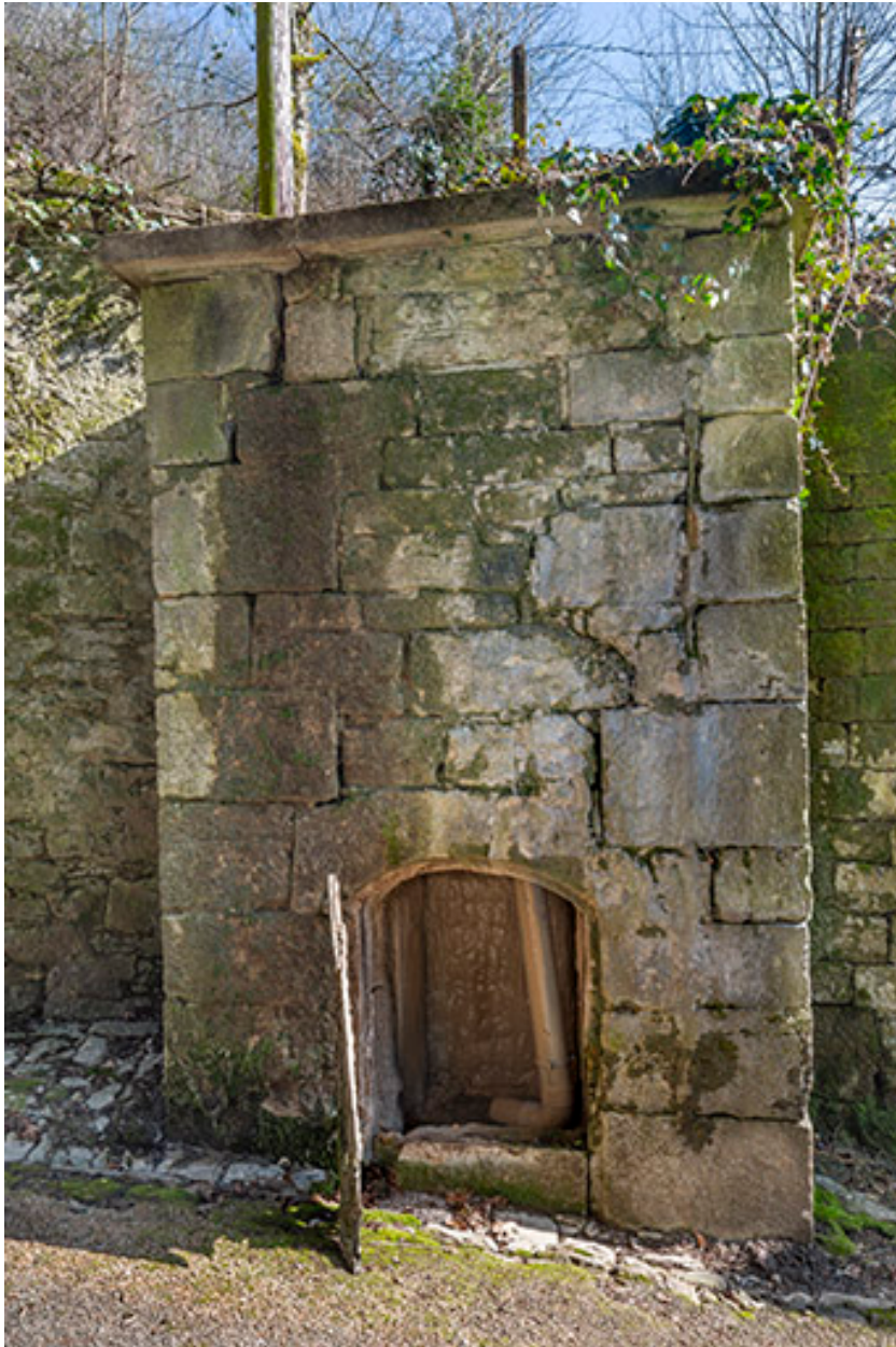
Escalier de Saint-Anatoile. Vue rapprochée du captage.
