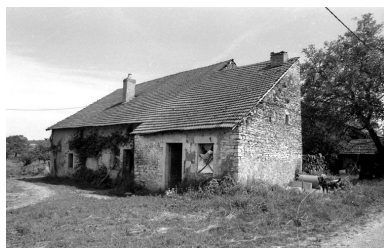
Bâtiment annexe dans la cour. Phot. Bernard Lardière IVR43_19817000606Z
