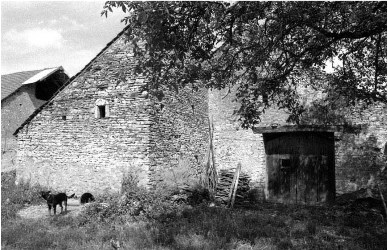
Remise et four : façade sur rue.
