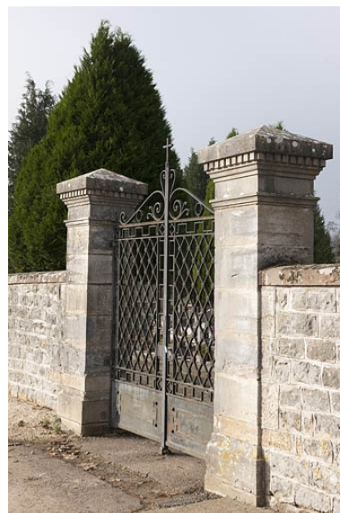
Le portail, vu de trois quarts droit. Phot. Jérôme Mongreville IVR43_20112502933NUC4A
