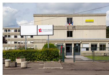
Entrée principale, façade est de l'administration. Phot. Sonia Dourlot IVR43_20142501015NUC2A
