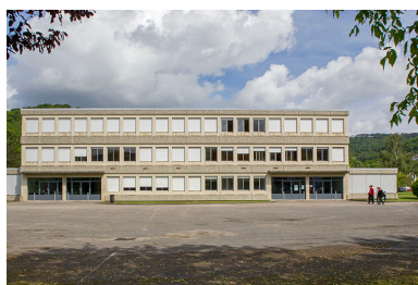
Façade sud-est sur cour de l'externat. Phot. Sonia Dourlot IVR43_20142501034NUC2A
