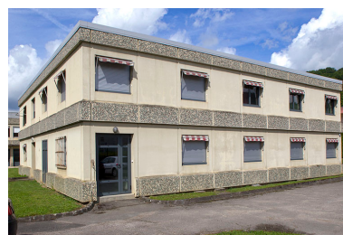
Façade est des logements. Phot. Sonia Dourlot IVR43_20142501057NUC2A
