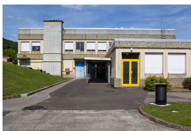
Façade ouest du bâtiment de restauration. Phot. Sonia Dourlot IVR43_20142501076NUC2A
