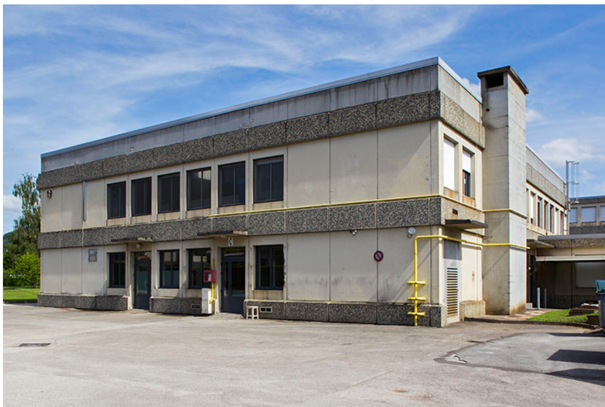
Façade nord du bâtiment de restauration.
