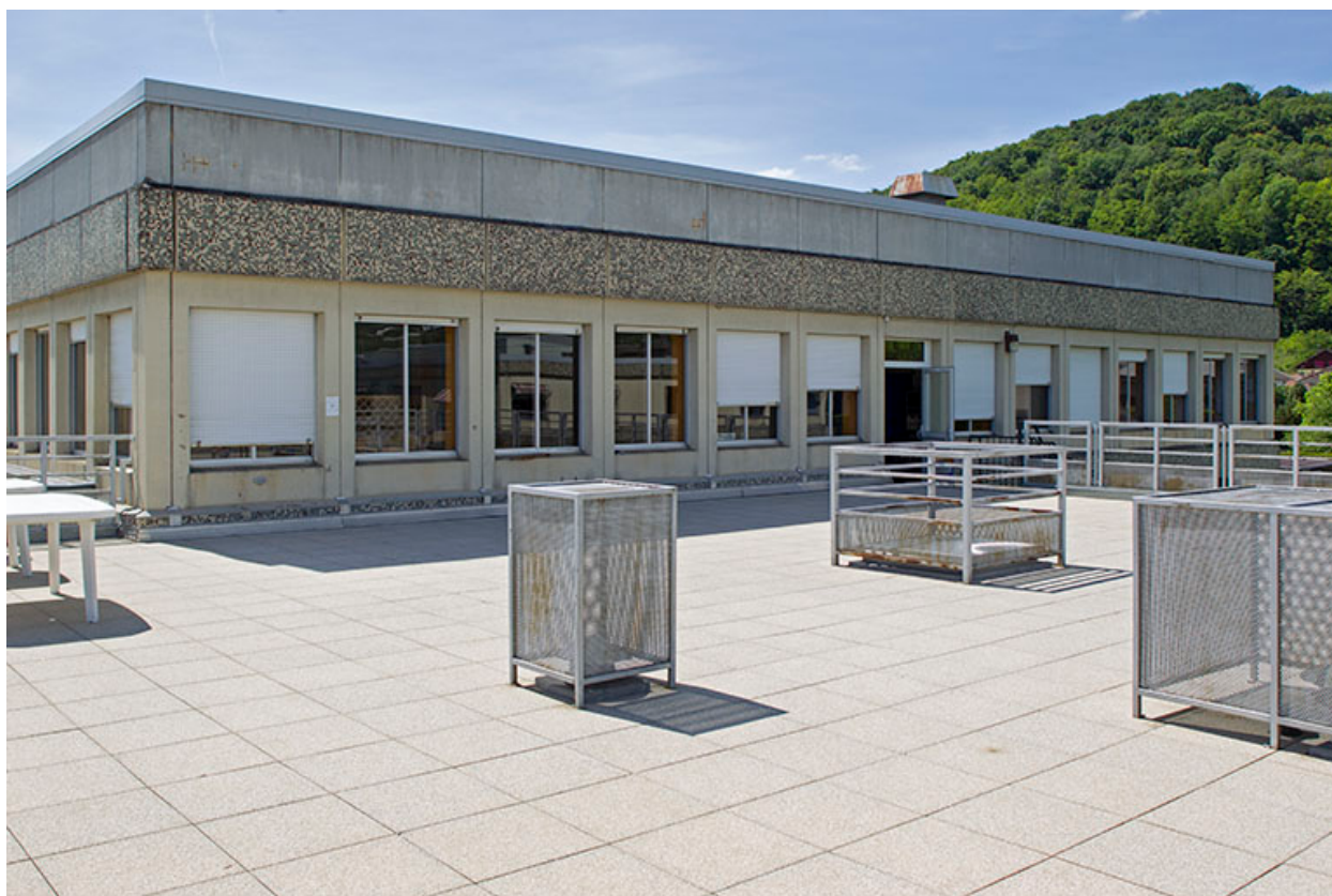
Sur la terrasse de la restauration.
