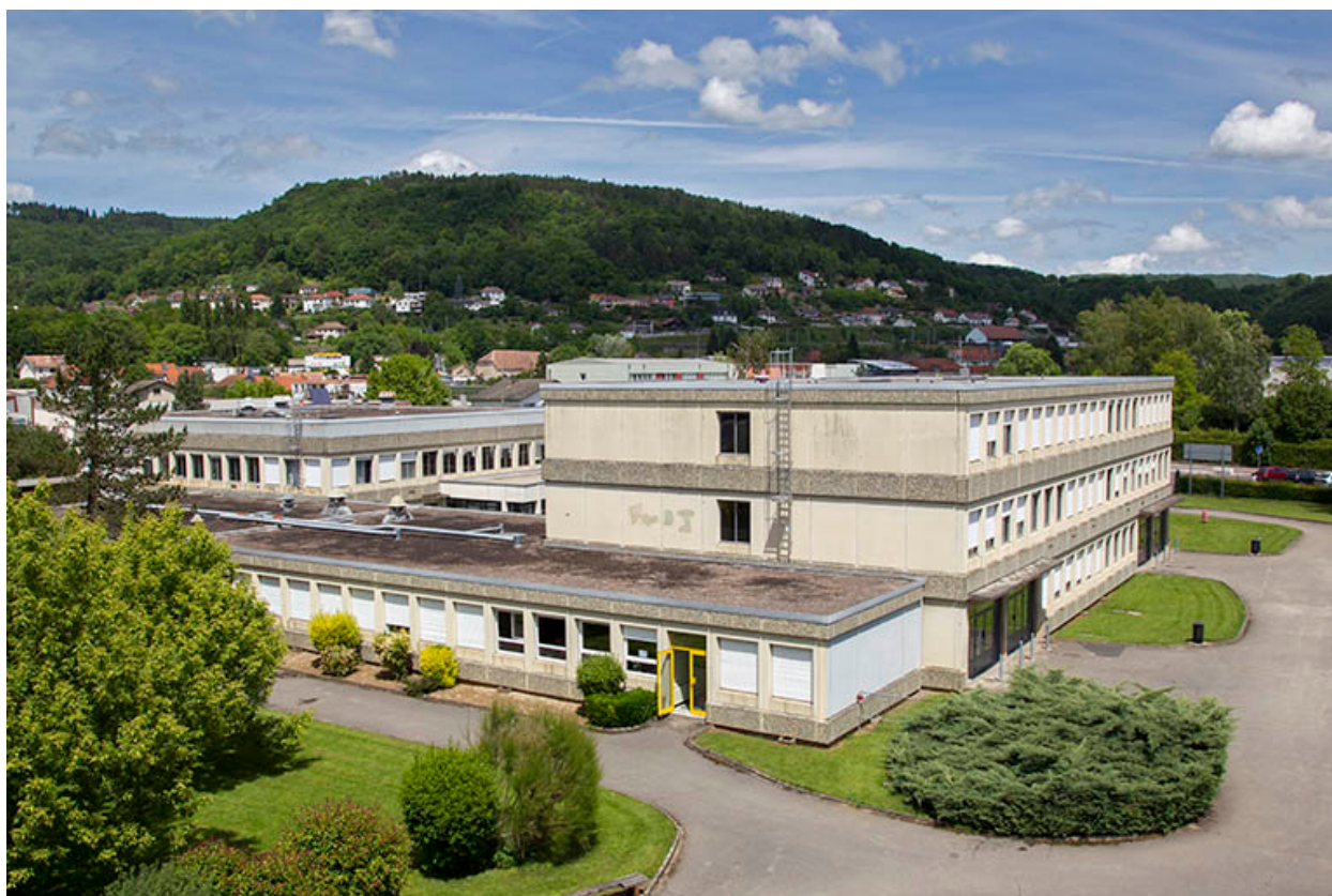
Angle sud de l'externat, vu de l'internat.
