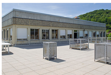
Sur la terrasse de la restauration. Phot. Sonia Dourlot IVR43_20142501075NUC2A
