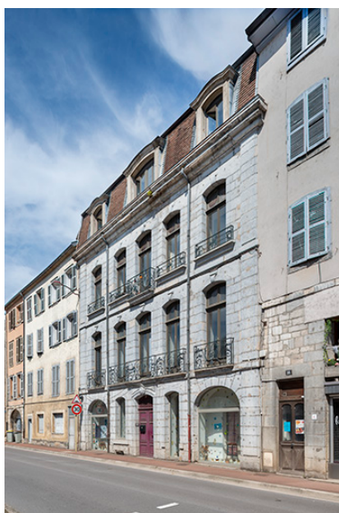
Vue de trois quarts droite. Phot. Jérôme Mongreville IVR43_20233900862NUC4A
