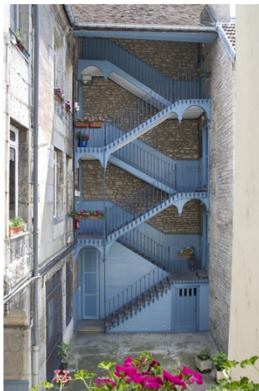
Vue d'ensemble de l'escalier à cage ouverte à gauche de la cour. Phot. Yves Sancey IVR43_20102500756NUC2A
