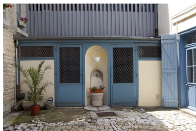
Détail de la borne fontaine et du rez-de-chaussée du séchoir. Phot. Yves Sancey IVR43_20102500757NUC2A
