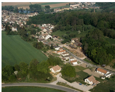
Vue d'ensemble depuis l'est, photographie aérienne. Phot. Yves Sancey IVR43_19903900209XA
