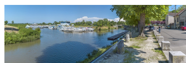
Vue d'ensemble du port depuis le perré. A droite, le chenal d'accès et au fond, la capitainerie. Phot. Thierry Kuntz IVR26_20162101296NUC4A
