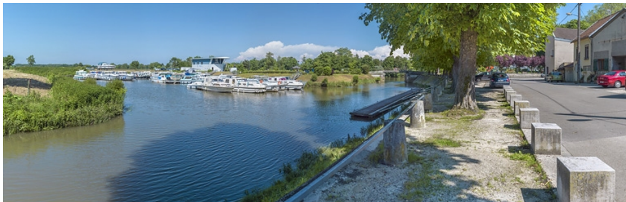
Vue d'ensemble du port. A droite, le chenal d'accès et au fond, la capitainerie.
